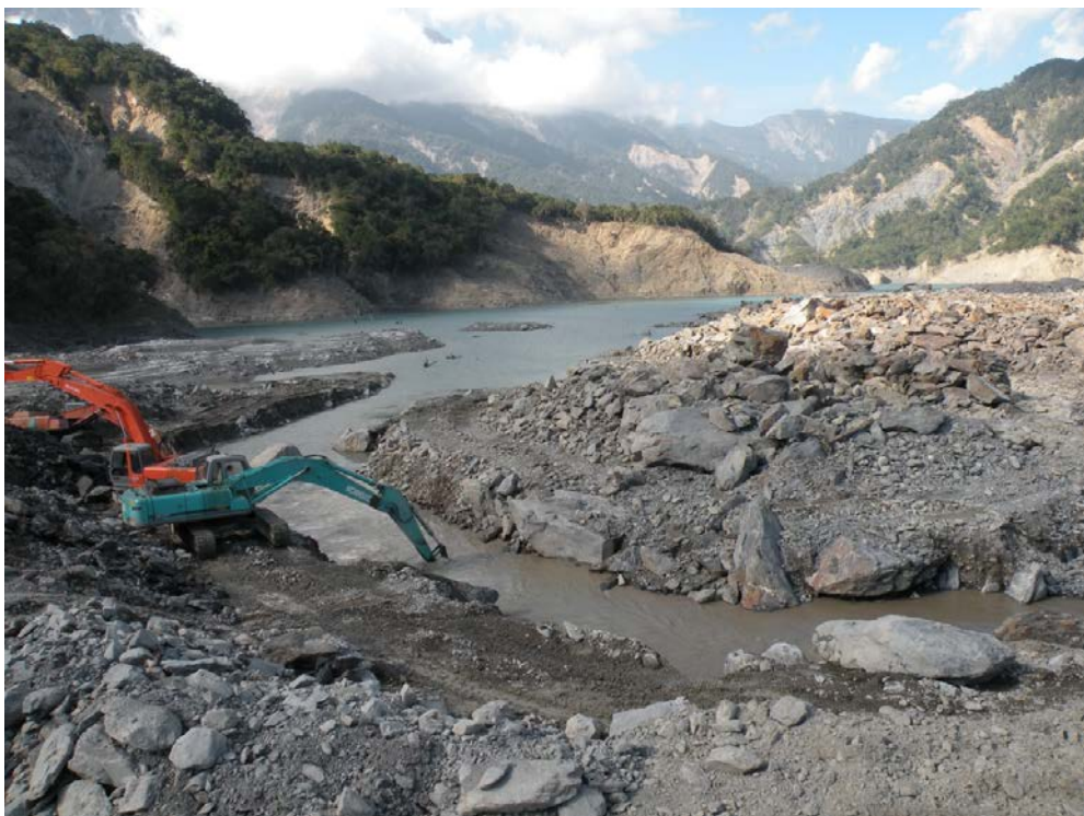
圖 4-57 包盛社堰塞湖天然壩溢流水道降挖作業情形
