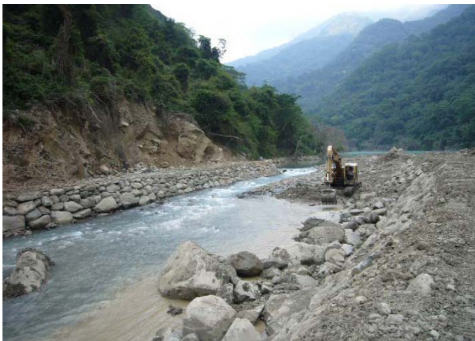
圖 4-41 旗山溪堰塞湖溢流道降挖工程
