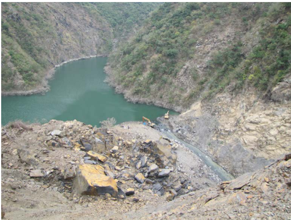
圖 4-50 士文溪堰塞湖溢洪道降挖工程
