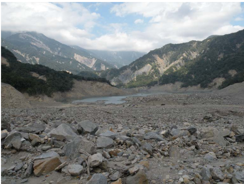
圖 4-58 包盛社堰塞湖天然壩溢流水道降挖後堰塞湖狀況
