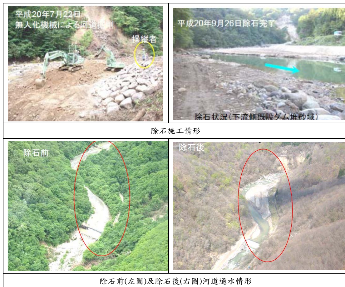
圖 5-26 溫湯地區河道除石削掘施工情形
