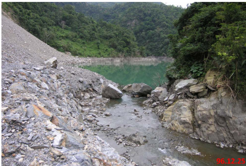
圖 4-29 龍泉溪堰塞湖第一次降挖工程
