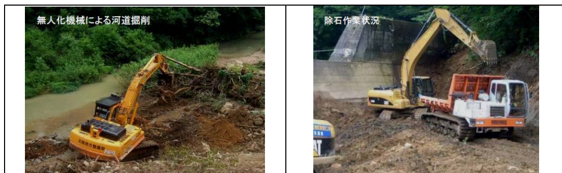
圖 5-36 產女川地區河道削掘及除石施工作業情形
