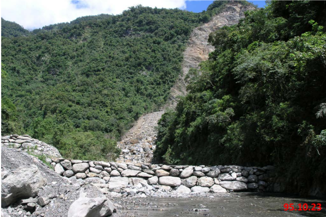
圖 4-27 龍泉溪堰塞湖緊急砌石防砂壩
