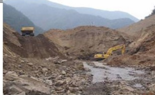
↑臨時排水路施工狀況
