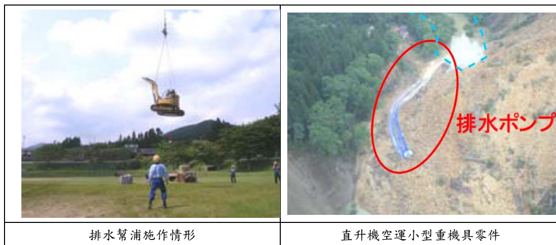
圖 5-30 湯之倉溫泉地區堰塞湖緊急施工作業情形
