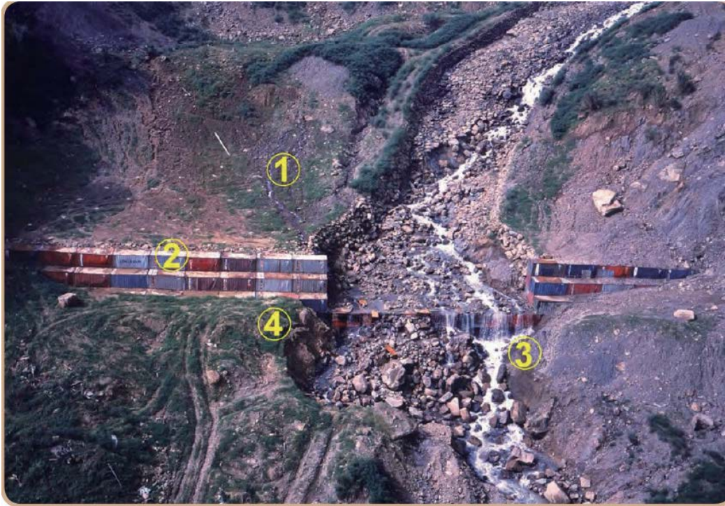
◎ 坡趾壓重工程照片 (2000年9月攝) ① 坡面滲出水, ② 貨櫃體, ③ 溢流口, ④ 貨櫃壩基礎
