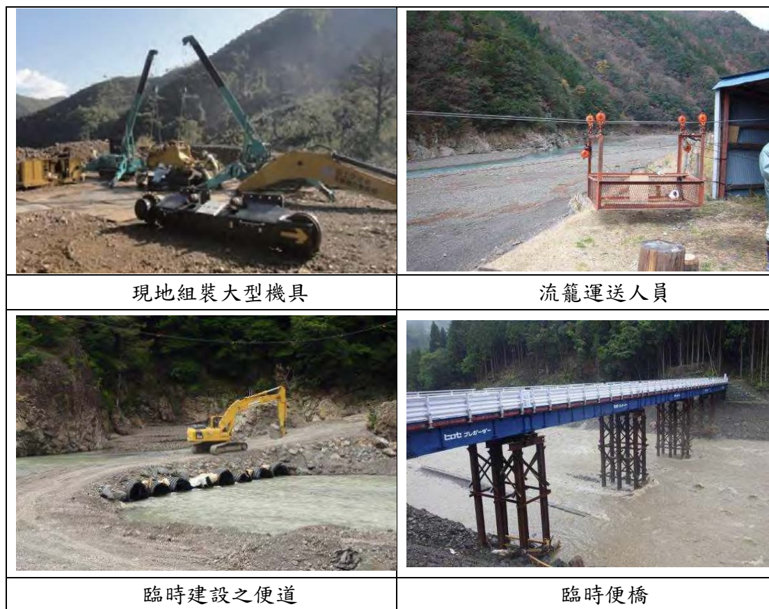
圖 5-61 長殿地區施工用道路建設紀錄
