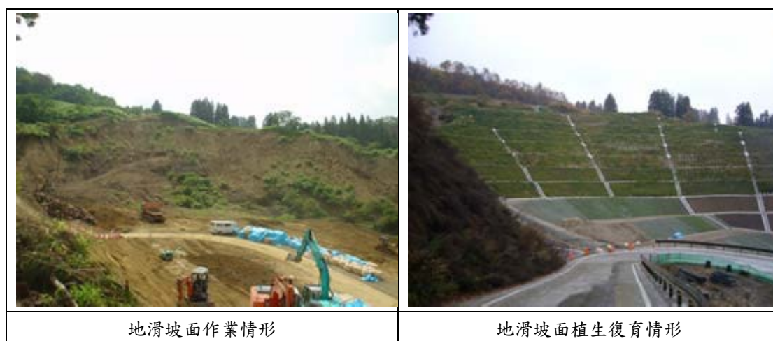
圖 5-15 寺野地區地滑坡面穩定工程
