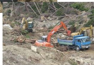
↑臨時排水路施工狀況
