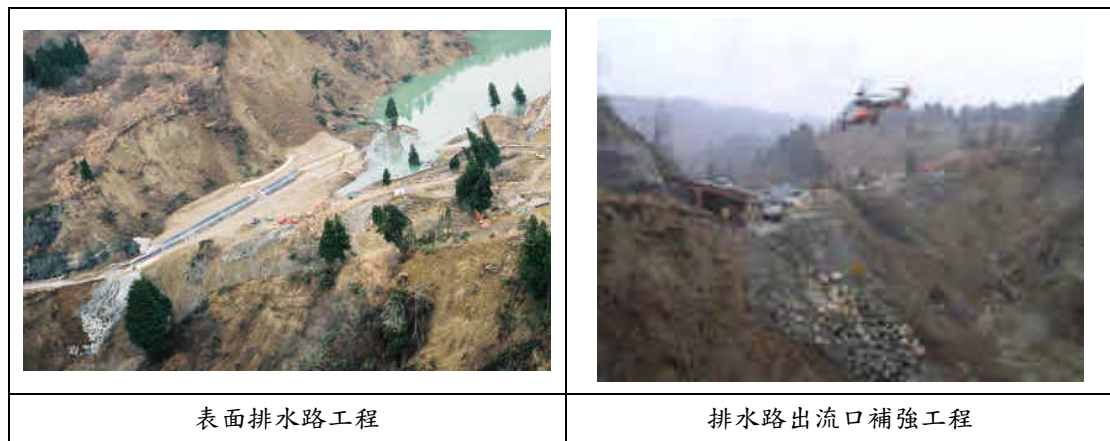
圖 5-9 寺野地區表面排水路設置狀況
