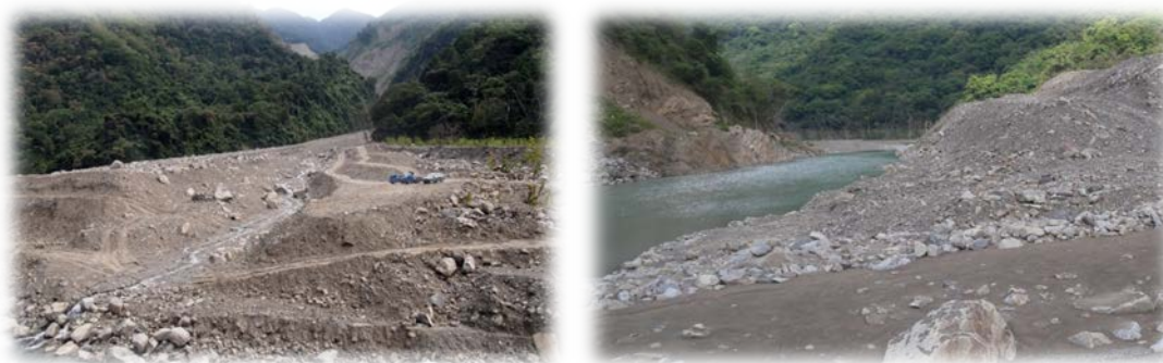
圖 4-42 旗山溪堰塞湖支流河道整理
