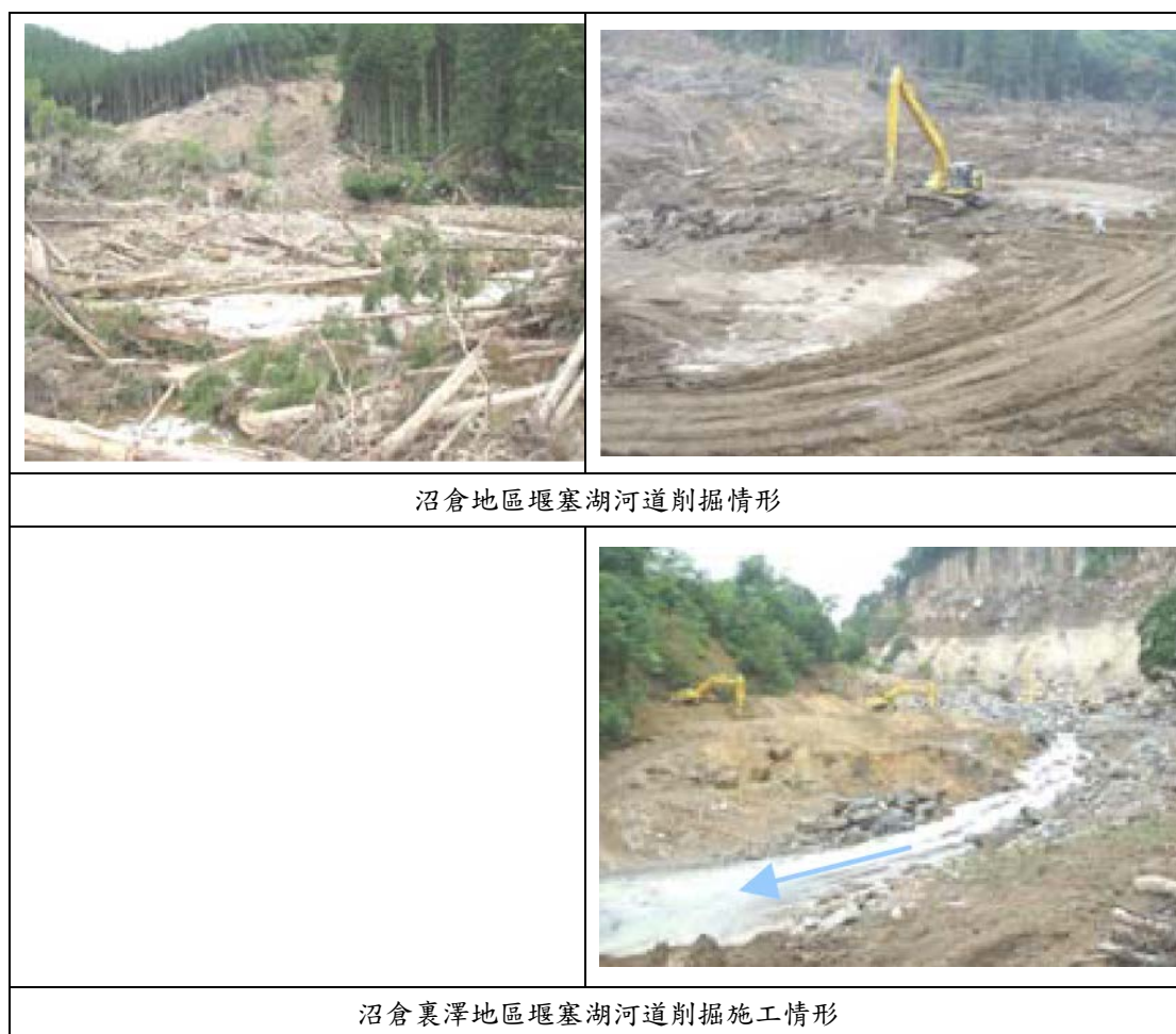
圖 5-28 沼倉地區河道削掘施工情形
