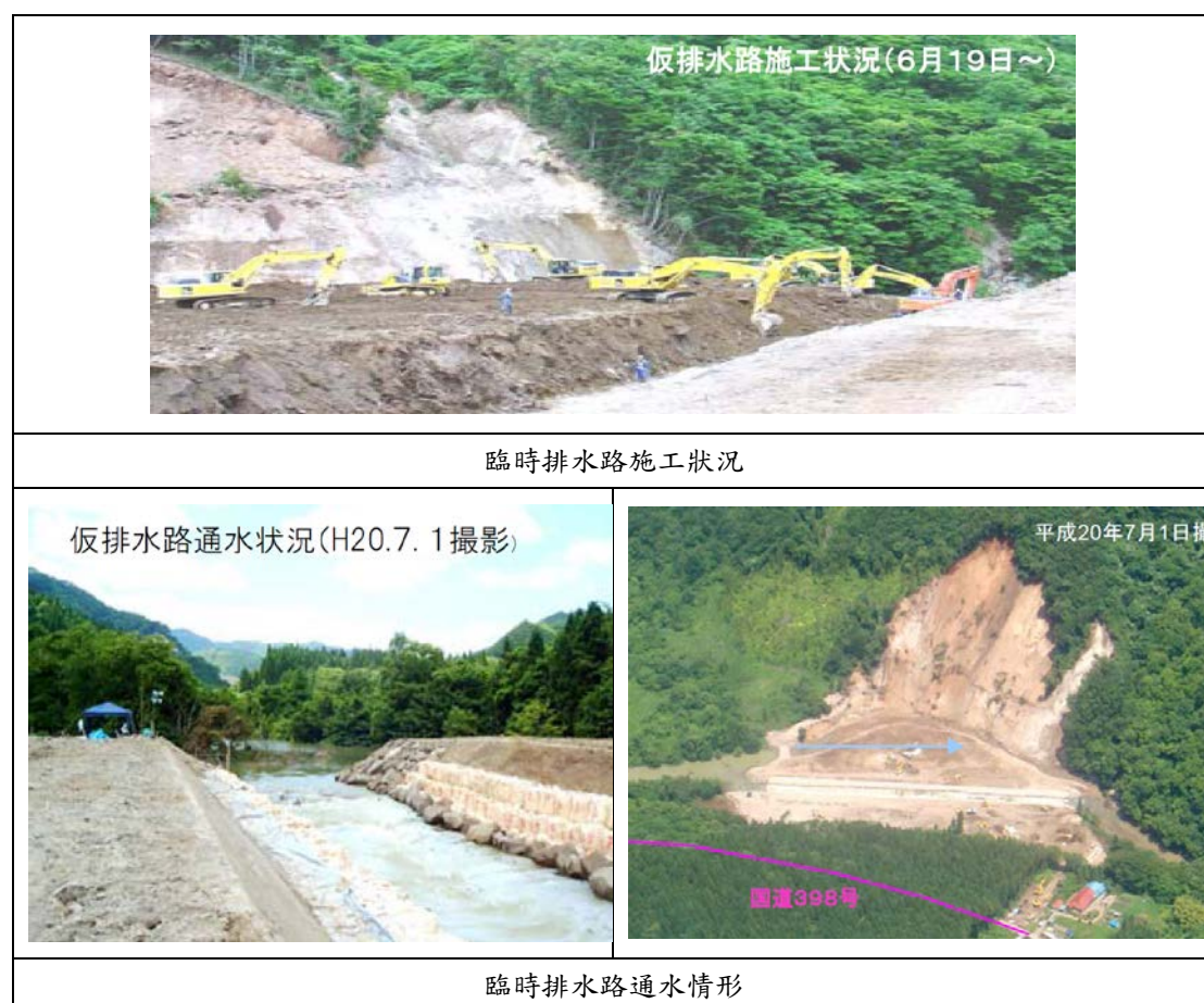
圖 5-22 淺布地區臨時排水路設置狀況
