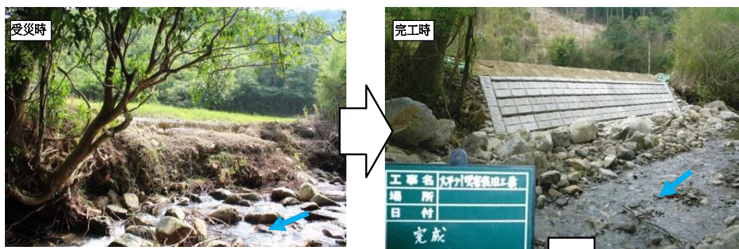
照片 2.43 堆石與堆土的岸邊多樣化與植生復舊案例（三刀屋川：島根縣）
