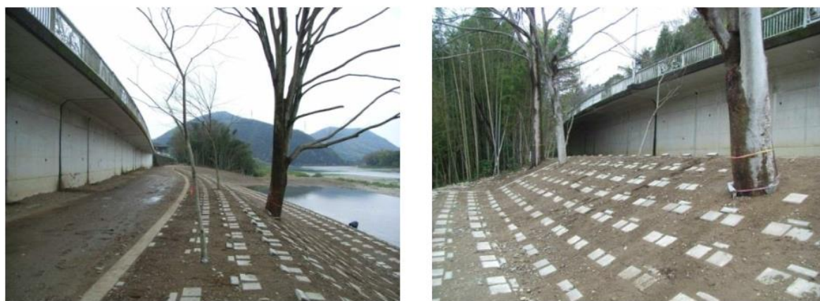
照片 2.11 低水流量河道護岸整備、保全河畔樹木的案例(長良川：岐阜縣)
