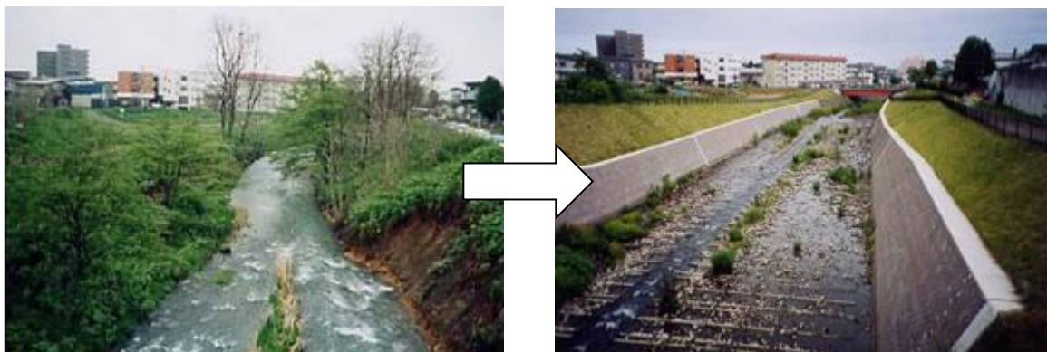
整治前植生覆蓋的河岸，以及整建完工後的混凝土塊護岸河岸，粗糙度明顯不同
