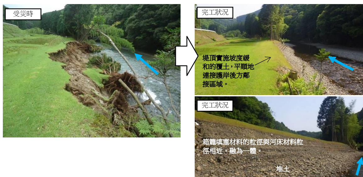
圖 2.45 箱籠恢復植生與防止土砂流出方法案例
