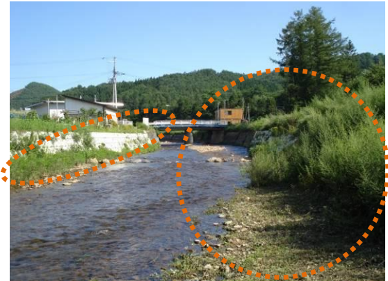
照片 2.15 現地生成材料實施堆石而形成自然岸邊的案例（元町川：岩手縣）
