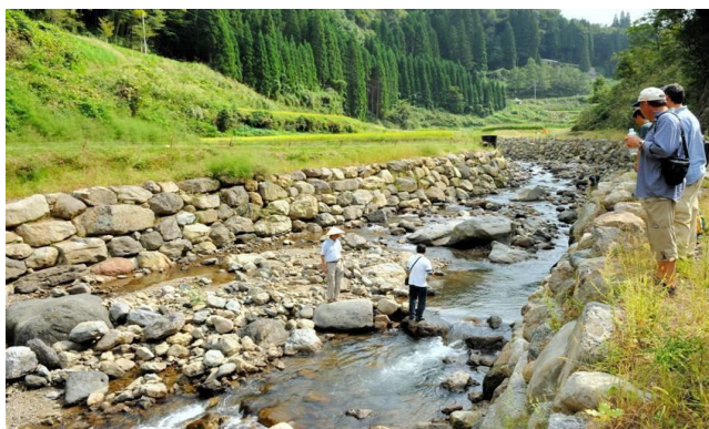
照片 2.51 受災後河床出現巨礫發揮固床工效果的保全案例（山附川：宮崎縣）
