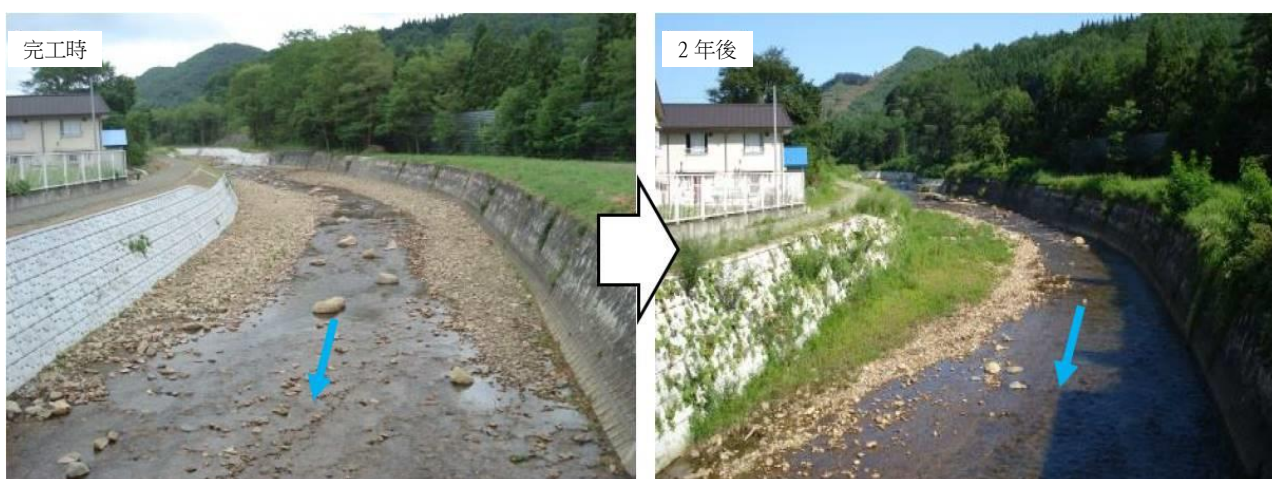
照片 2.4 災害復舊過程中保全深槽線的案例(矢神川：岩手縣)
