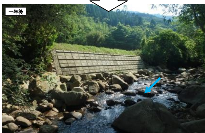
照片 2.44 運用河床材料適性、實施堆石的案例（大平川：宮崎縣）
