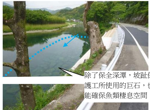
照片 2.9 除了保全河道彎曲段的深潭，也保全魚類棲息空間的案例(新莊川：高知縣)
