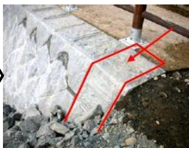
· 紅框部分橫帶使用可避免混凝土剝離的坡面鋪石，形成整體和諧感。(寬度達 30cm 左右，不採用斜交疊砌，而做成水平疊砌)
