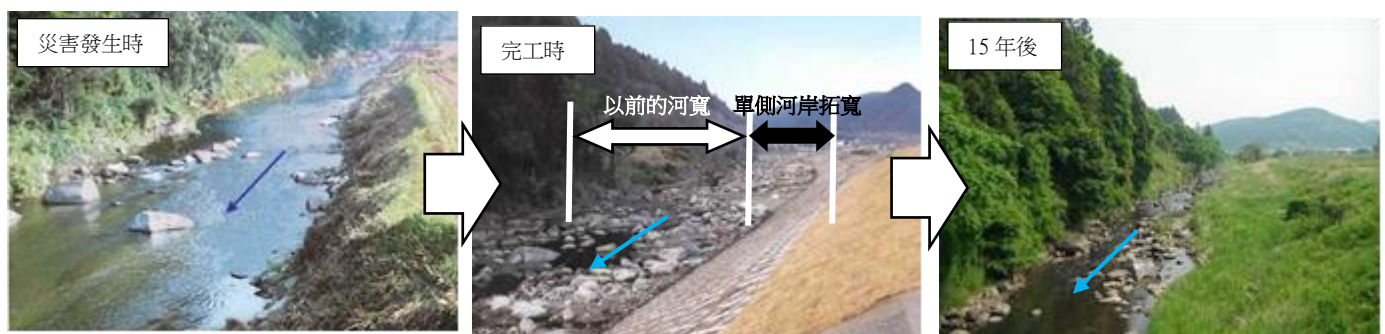
照片 3.14 實施單側河岸拓寬並保全低水流量河道環境的復舊案例（三藏川：栃木縣）
