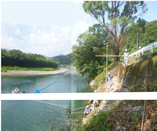
照片 2.9 除了保全河道彎曲段的深潭，也保全魚類棲息空間的案例(新莊川：高知縣)
