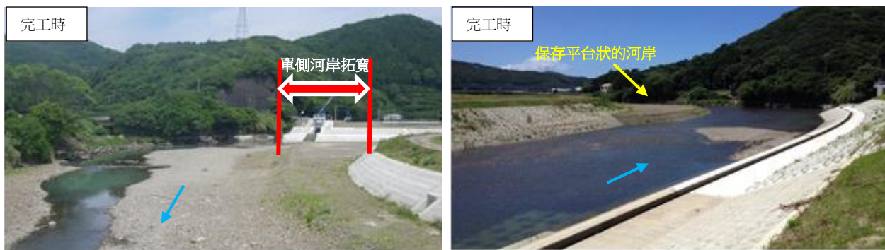
照片 3.12 實施單側河岸拓寬並保全低水流量河道環境的復舊案例（切木川：和歌山縣）
