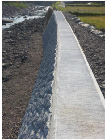
照片 2.52 掃帚掃過堤頂混凝土表面的案例
