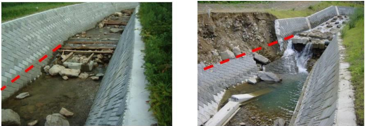
照片 2.6 整治後逕流水(洪水)導致護岸破損的案例
