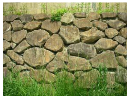
開挖石材疊砌而成的河川護岸 (天然石、隨意疊砌)(宮城縣、廣瀨川)
