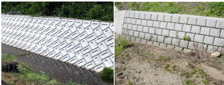
照片 2.23 斜交疊砌法（左）與水平疊砌法（右）的景觀模式
