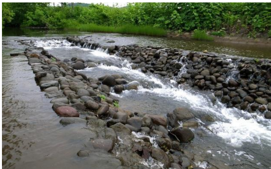
照片 2.49 下游區間河床下降時切掉部分階段工（跌水工）維持急灘構造、確保水流連續性的案例（俱登山川：北海道）
