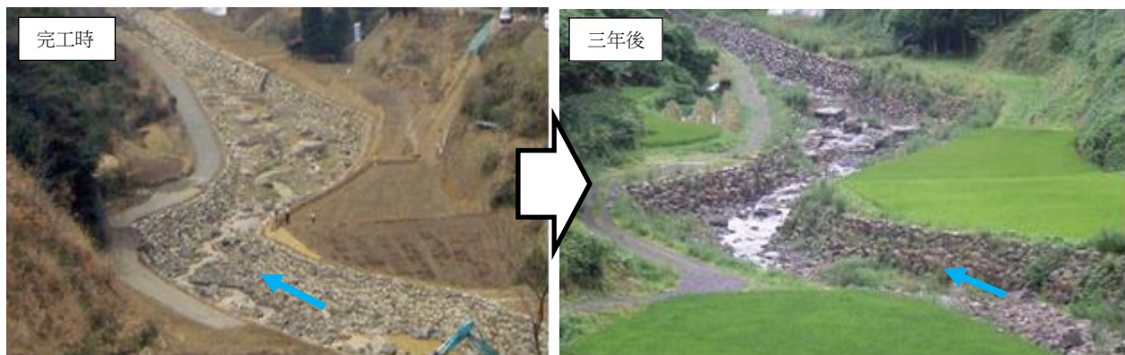
照片 3.11 活用復舊前的河川蜿蜒狀況與河道坡面坡度變化、實施河道復舊的案例 （山附川：宮崎縣高千穗町）
