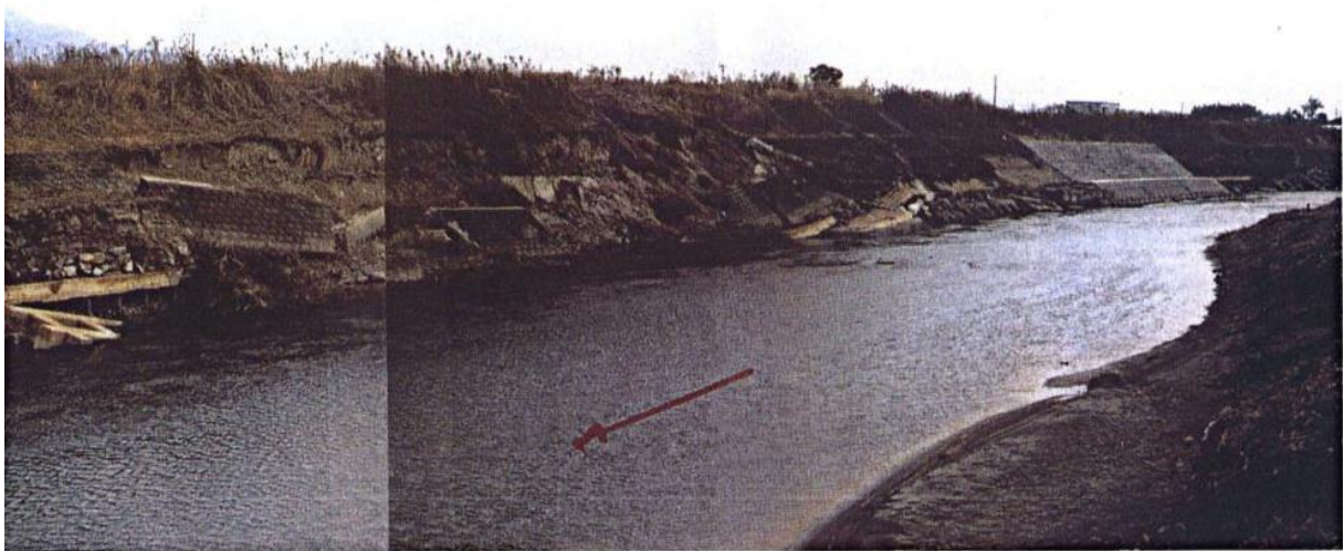
照片 2.46 災害狀況 混凝土塊護岸受災
