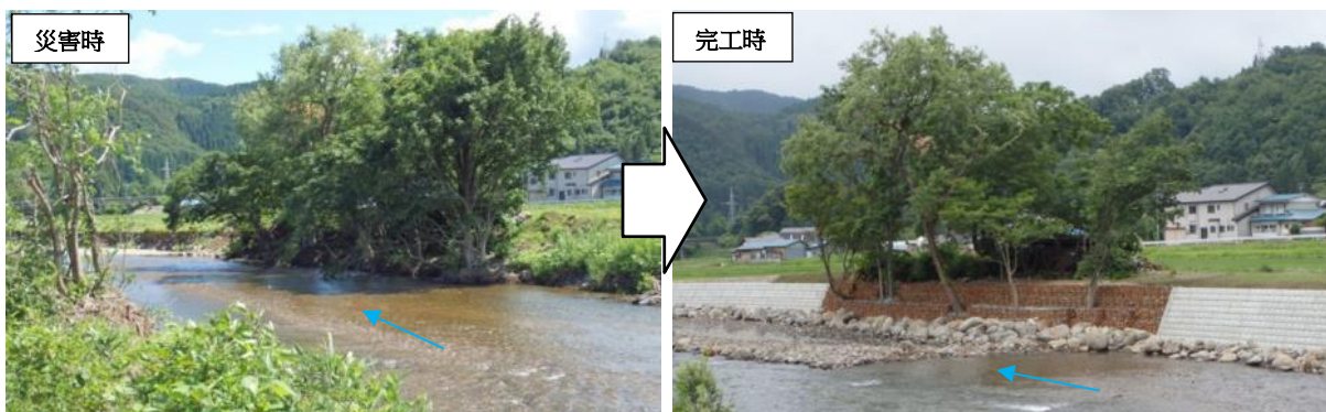
照片 3.17 實施河床下挖、保全河畔樹木的復舊案例
