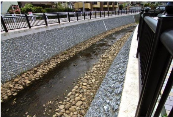
照片 2.14 外露護岸與直線水岸線案例（左）與濱水帶復育完成的案例（右）
