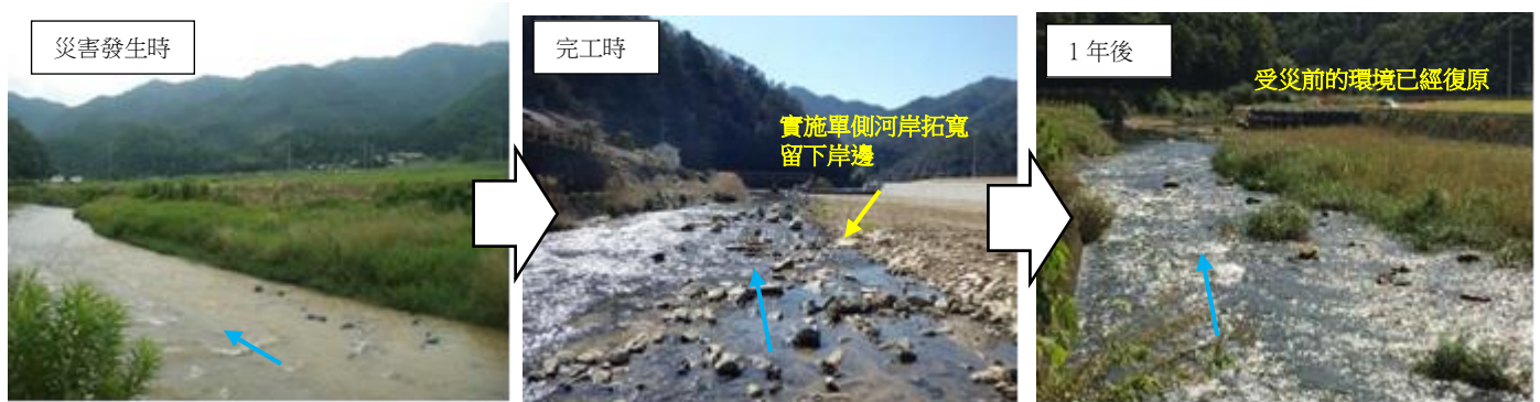
照片 3.13 實施單側河岸拓寬並保全低水流量河道環境的復舊案例（阿武川：山口縣）
