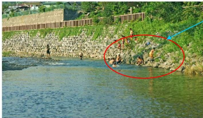
照片 2.9 河岸突出構造形成深潭的案例(平井川：東京都)
