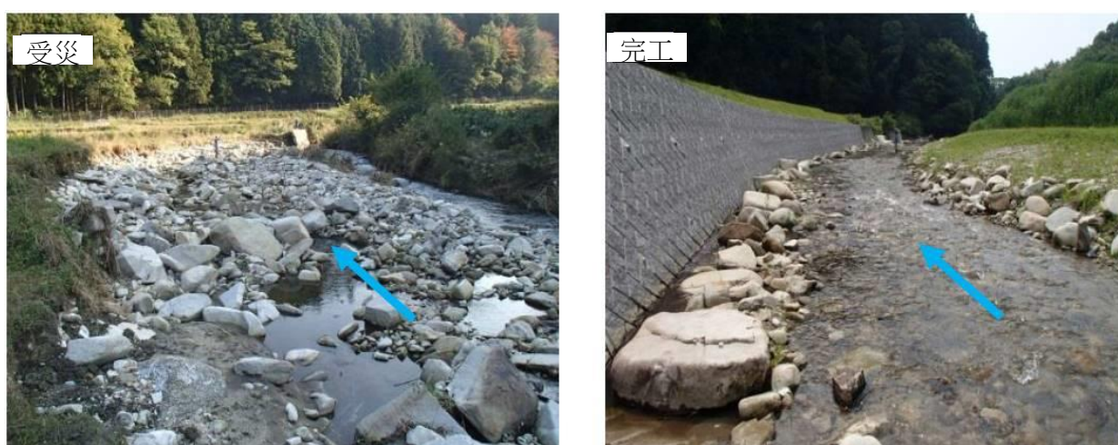
照片 2.12 移除河床巨礫的案例
