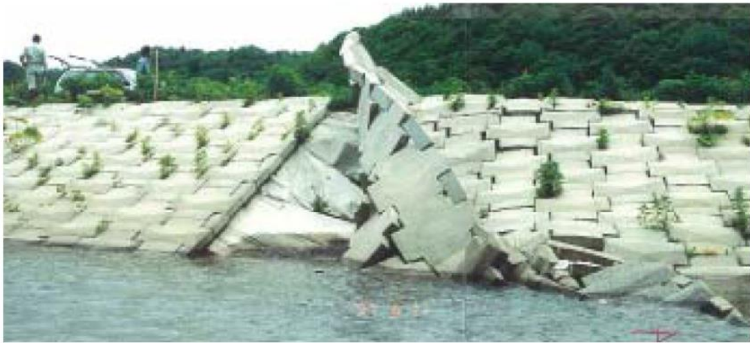
照片 2.2 流體力導致預鑄混凝土塊翻轉的災情案例
