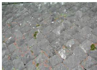
切割石材疊砌成為河川護岸 (四角石材、斜交疊砌)(秋田縣、橫手川)
