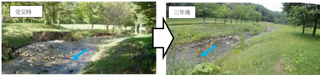
照片 3.9 盡量保持復舊前河道蜿蜒狀況的河道復舊案例（牧佐內川：北海道）
