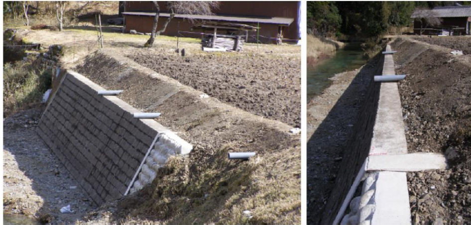
照片 2.53 堤頂混凝土表面鋪設碎石的案例
