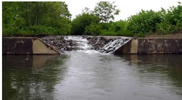
照片 2.49 下游區間河床下降時切掉部分階段工（跌水工）維持急灘構造、確保水流連續性的案例（俱登山川：北海道）
