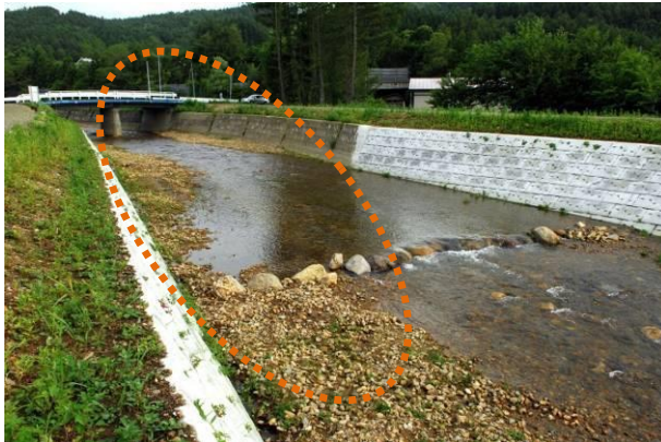
照片 2.15 現地生成材料實施堆石而形成自然岸邊的案例（元町川：岩手縣）
