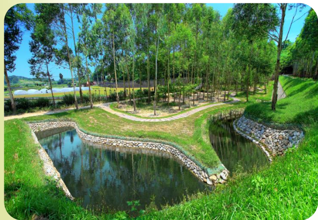
土砂災害治理
