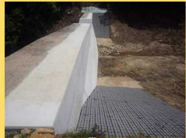
<修繕・補強後>
