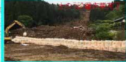
土のう設置作業中
