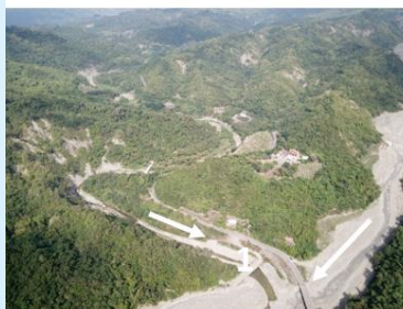
(e) 簡堤橋上游油礦溪右岸崩塌
