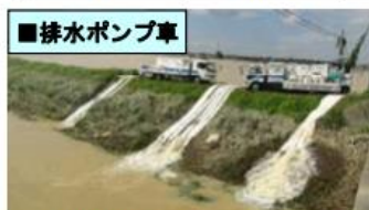
【 H27.9 関東・東北豪雨 】 (茨城県常総市)
