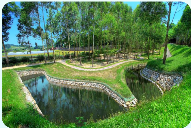
土砂災害治理
