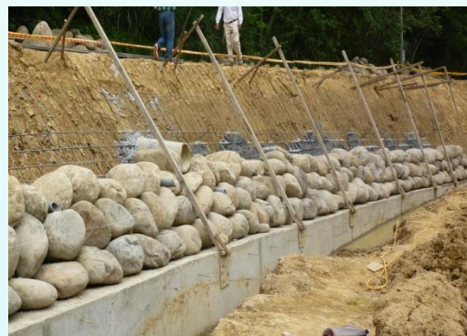
軟性工法-以植生塊石取代鋼筋混凝土
