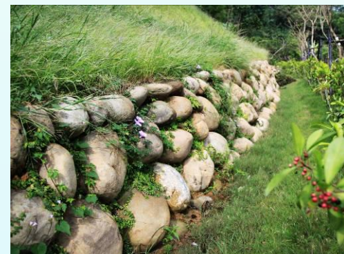
軟性工法-以植生塊石取代鋼筋混凝土
