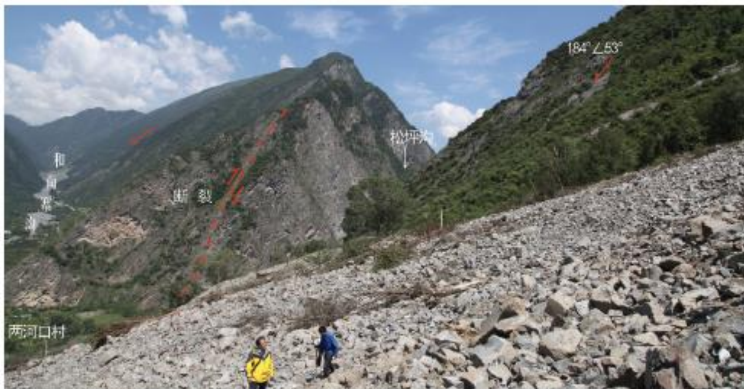
(a) 滑坡西侧斜坡及断裂（镜头朝西）
