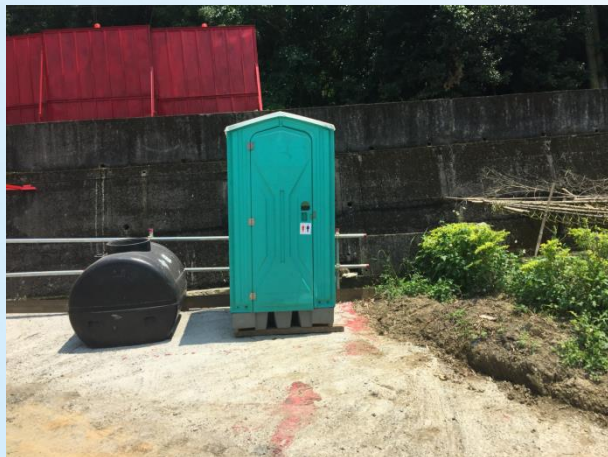
檢查是否設置流動廁所
