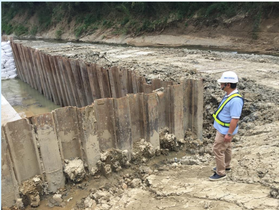
開挖擋土設施
