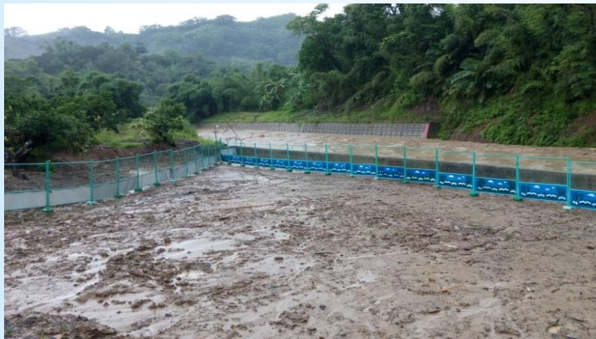
檢查現場是否設置臨水作業警示設施
