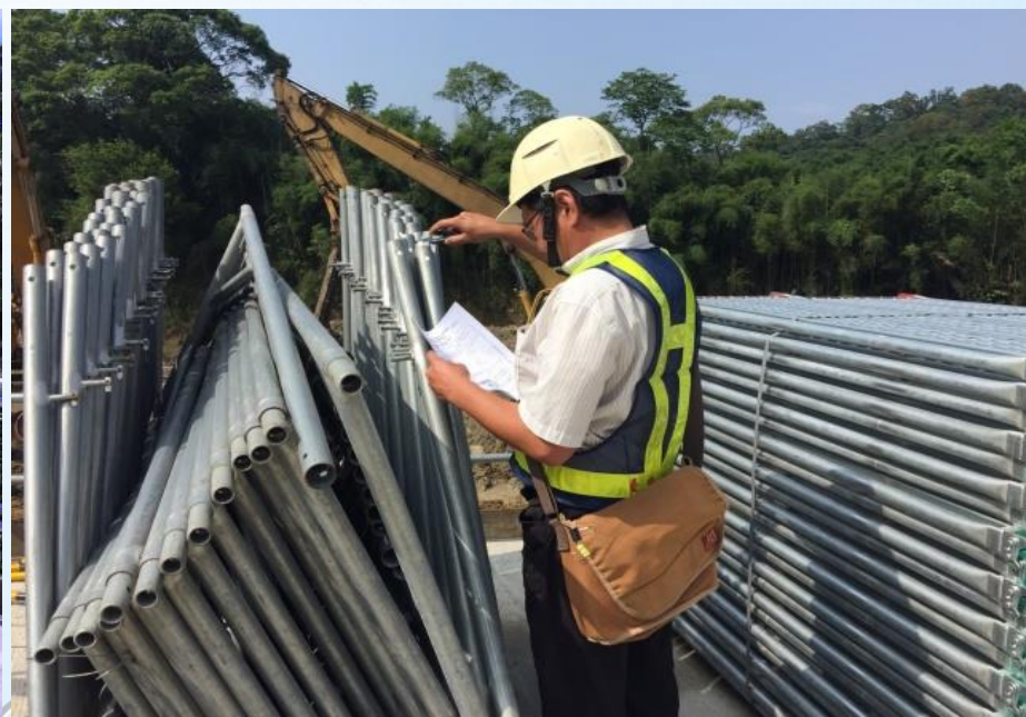
施工架鋼管厚度檢查
