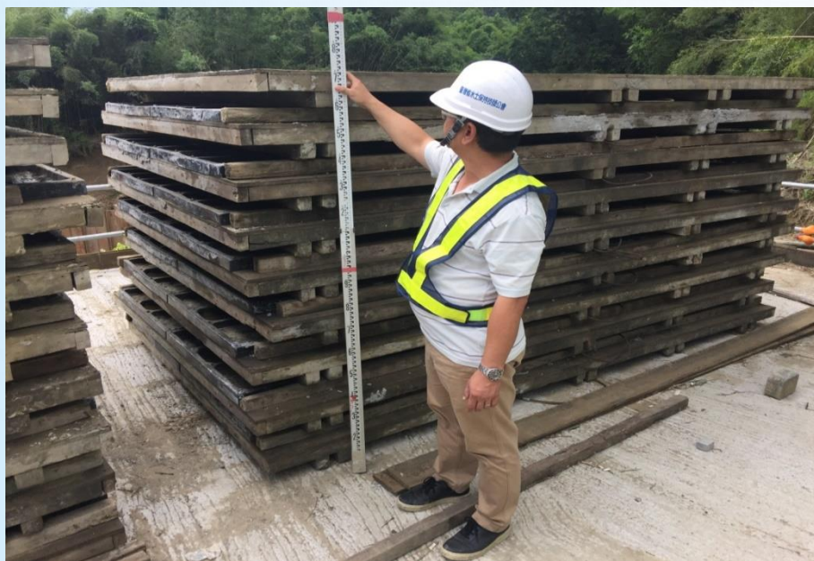
檢查模板堆置高度不得超過1.8m
