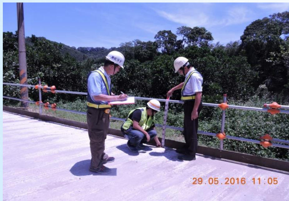
檢查護欄高度
