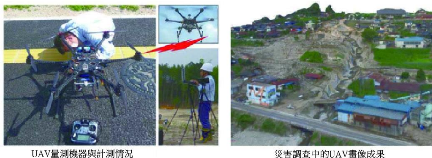
圖49 UAV（無人機）的活用狀況
