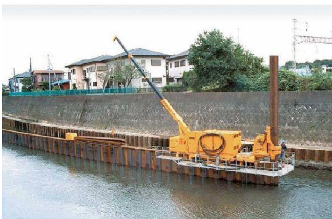
照片-2 水上施工案例
