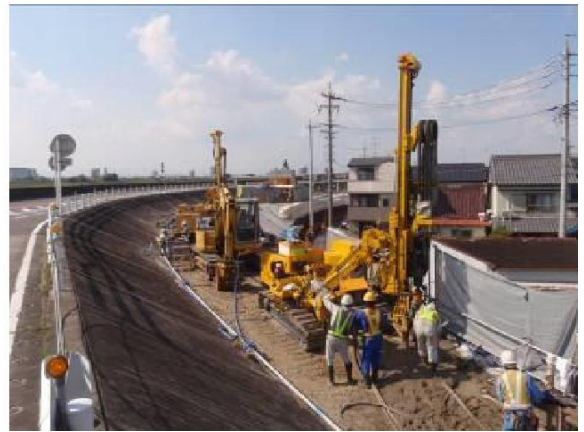
照片－2 SAVE-SP工法實施狀況
