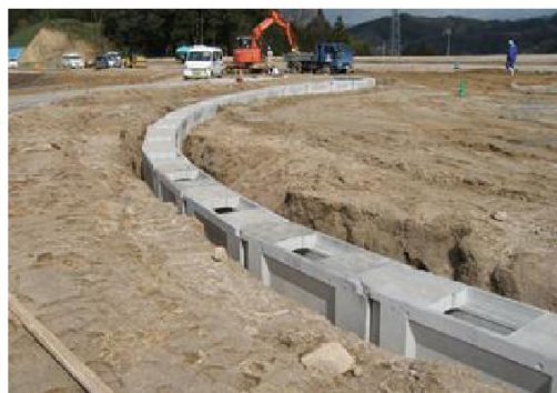
照片－2 施工狀況
