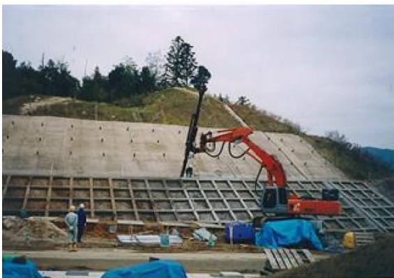
以怪手進行施工
