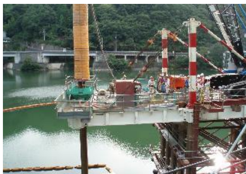
照片—1 單面支承架設與鋼板樁打設情形 (不需在水面與斜面設置導材)
