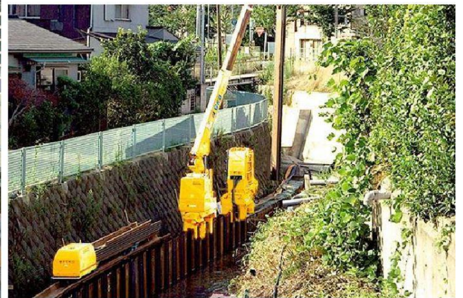
照片-1 狹隘地施工案例
