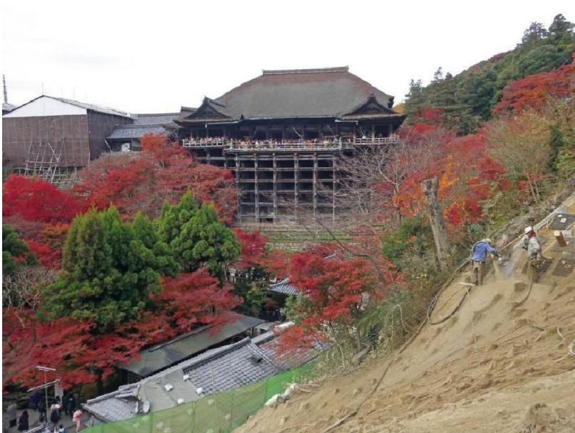
復舊工程施工狀況 (2013 年崩塌)
