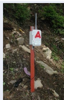
坡面崩塌感測儀的設置狀況
