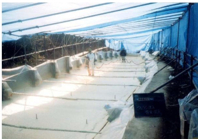
照片－1 施工狀況
