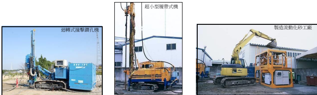
照片－3 施工機械與流動化砂製造機
