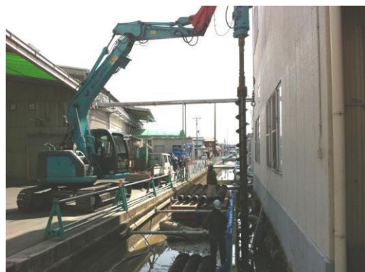
照片一 3 重機無法靠近的地點施工
