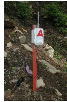
照片－2 坡面崩塌感測器的設置狀
