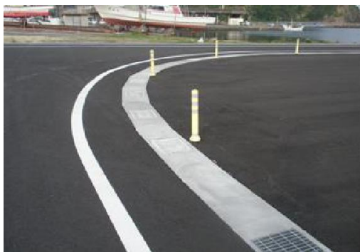
照片－5 彎道施工
