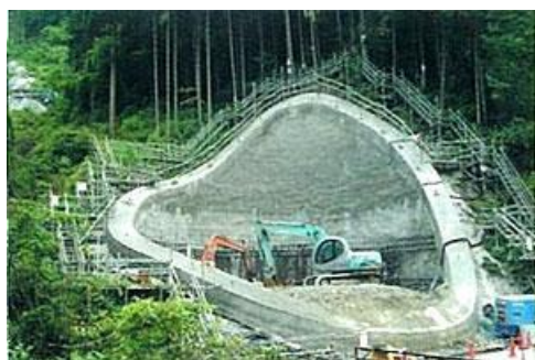
照片-3 開挖實況
