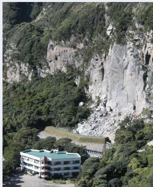
照片－1 大規模落石（岩盤 崩落）補充案例 東京都新島村
