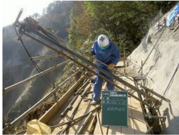
以單管作業平台施工的情形（使用輕型氣動式鑽孔機）
