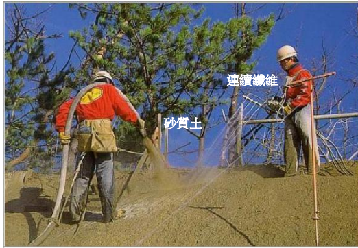
照片－1 連續纖維補強土施工狀況○○○○
