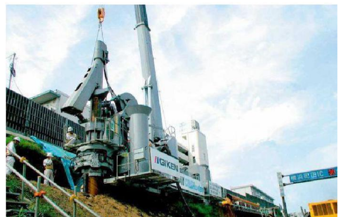
照片-3 坡面施工案例
