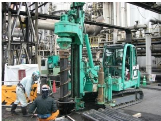
照片一 1 小型鋼板樁打設機施作
