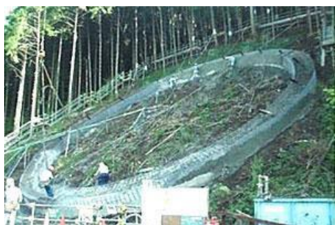
照片-1 環形樑施工情形
