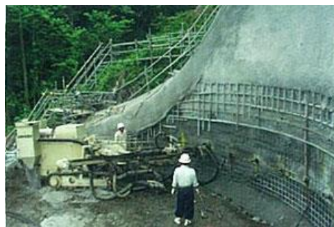
照片-2 施作岩栓
