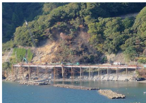
照片—2 救災、災區重建用臨時組合橋 (解決坡面崩塌導致聚落孤立的問題)
