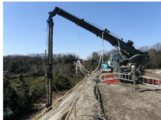
照片一 2 坡面施工案例
