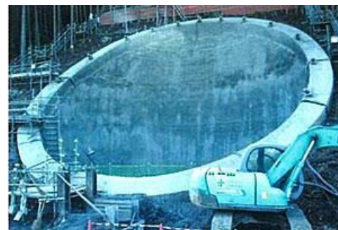
照片-4 完成噴凝土施作
