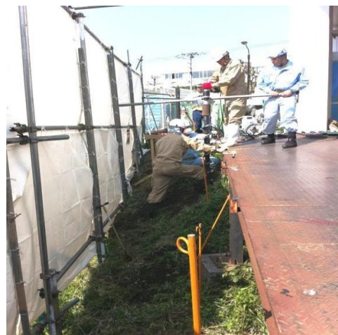
照片一 4 重機無法進入的場所 進行人力施工
