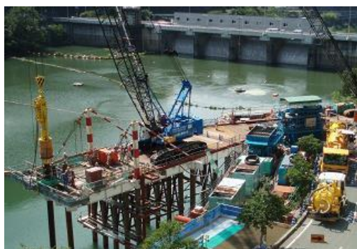
照片—4 水庫內施工 (可回收開挖土方、避免濁水擴散) 效率)
