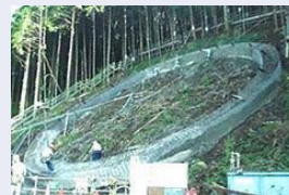
環樑施工狀況
