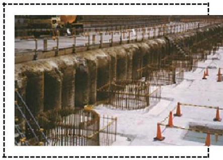
照片－7 自撐式擋土牆
