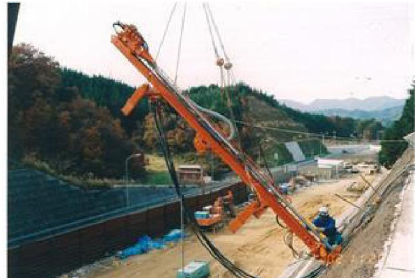
以吊車進行施工
