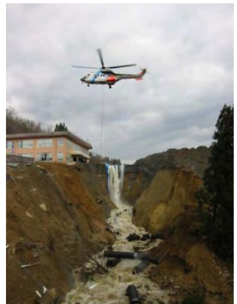
東竹澤地區的堤體侵蝕狀況 出處「2004年新潟縣中越地震所造成土砂災害及對應措施 H17.2 湯澤砂防辦公室」
