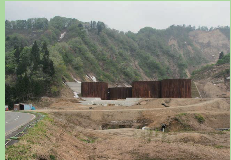
鐵鋼井桶防砂設施示意照片 (資料來源：日本 http://hachim.hateblo.jp/entry/ 網站)
