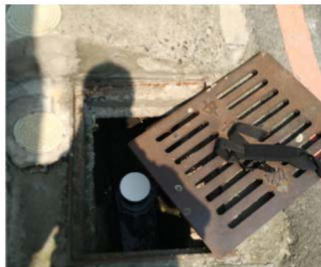
LoRa下水道水位監控系統
