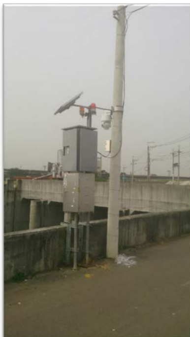
水位、雨量、影像即時監控系統
