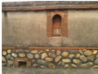
鄧屋伙房-天公爐
