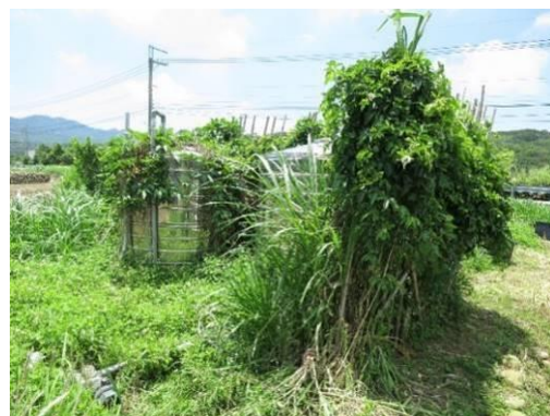
里山塾後面的儲水塔
