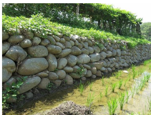
田邊石駁，石縫多孔隙，營造生態棲息的环境空間
