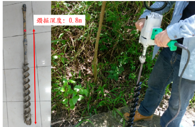
圖 4-3 以特製鑽桿鑽掘至預計埋設深度
