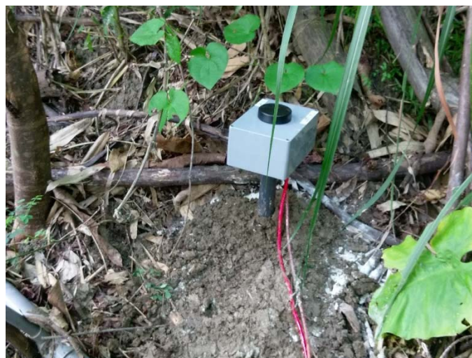
圖 4-5 模組架設完成
