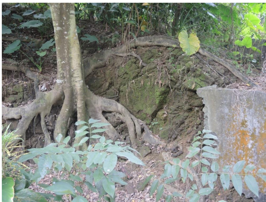
圖 5-8 高市 DF044 竹門路旁長枝坑層泥質砂岩邊坡
