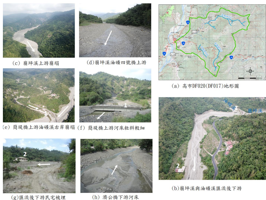
圖 5-12 高市 DF020 土石流潛勢溪流現勘
