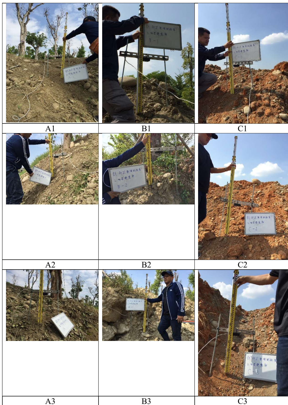
照片 3-8 三區試驗場地設備安裝試驗狀況
