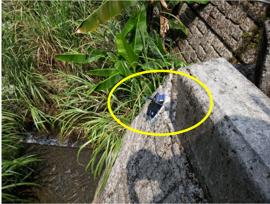
圖 2-24 崩山湖上游水位計安裝完成圖
