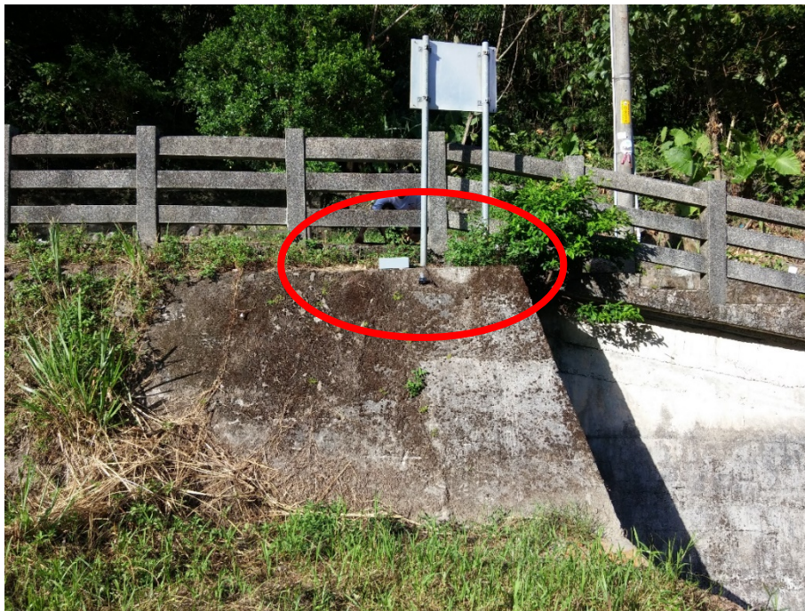
圖 2-33 五峰旗改良式水位計安裝完成圖
