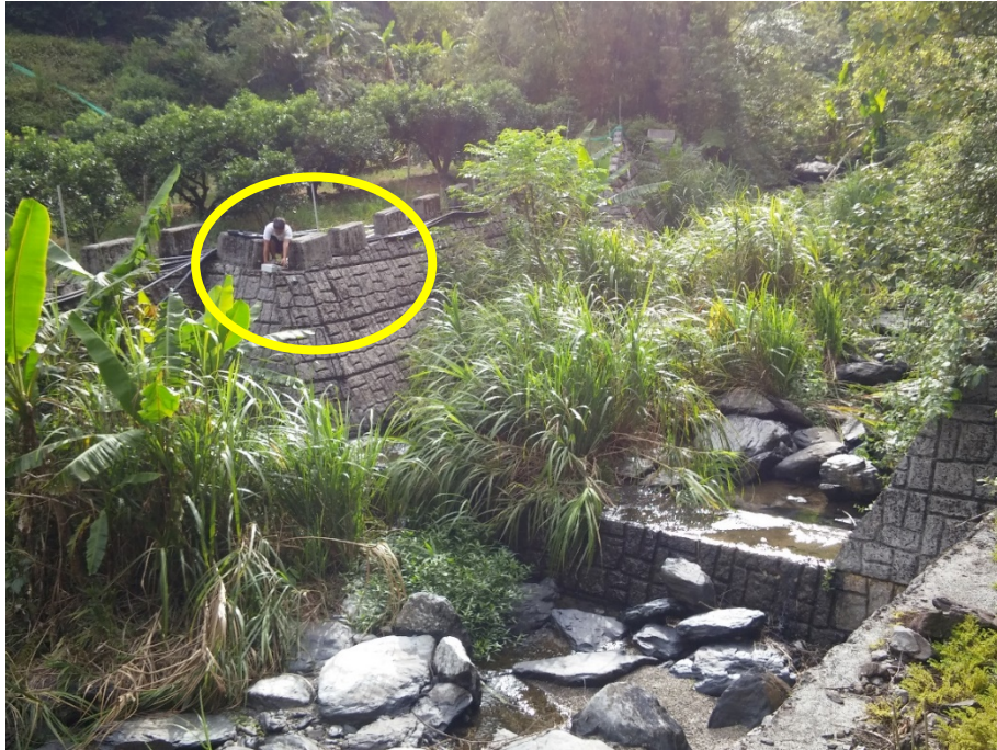
圖 2-26 崩山湖上游改良式水位計安裝完成圖
