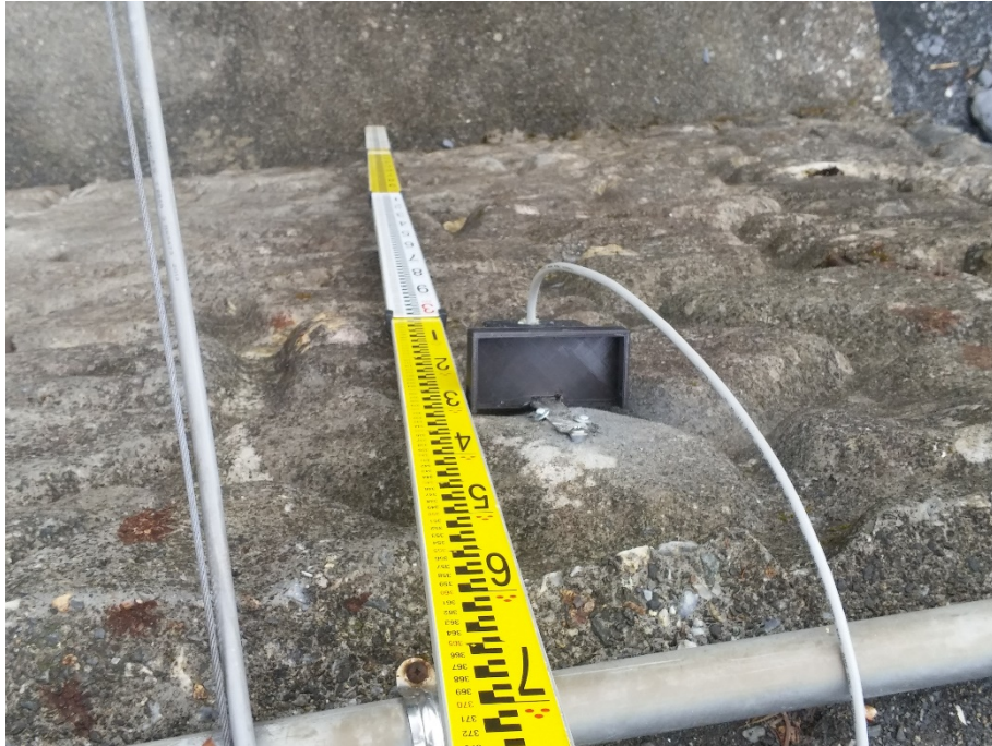
圖 2-34 寒溪改良式水位計偵測器安裝完成圖
