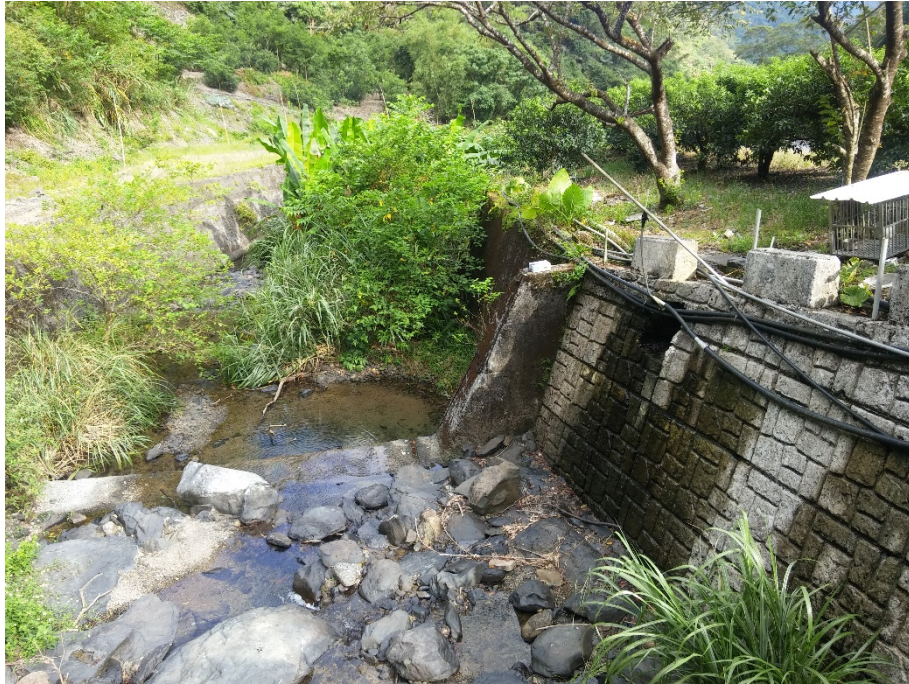
圖 2-30 崩山湖下游改良式水位計安裝完成圖
