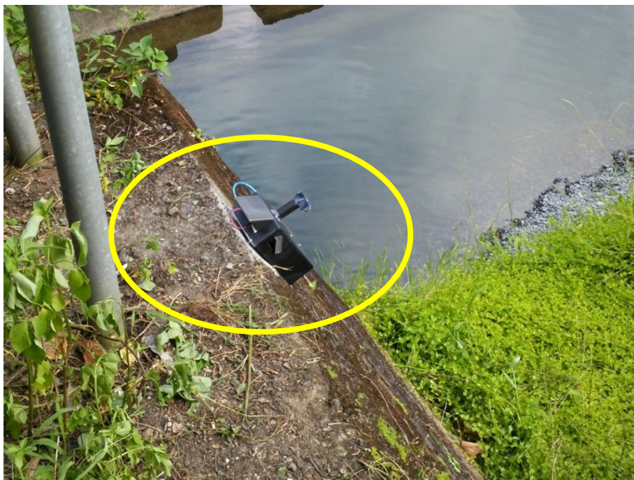
圖 2-31 五峰旗水位計安裝完成圖
