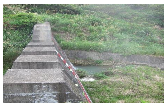
(羌黃坑社區上游設置的梳子壩)
