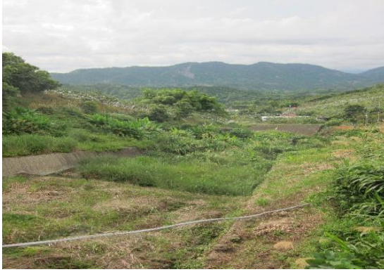
(從羌黃坑社區上游梳子壩往下俯視之疏洪溝渠)
