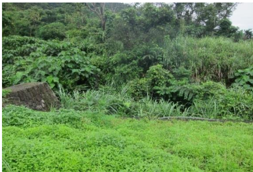
(已長滿雜草未清除的疏洪溝渠)
