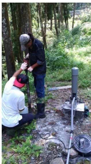
圖 4-28、鑽孔施工現場
