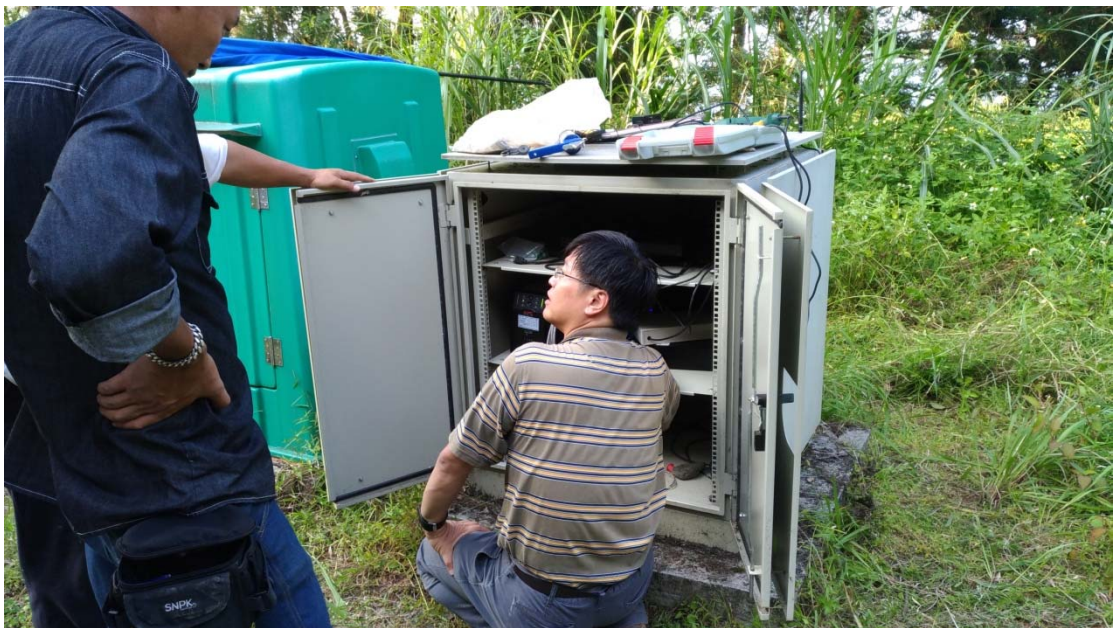
圖 4-32、安裝機房端的天線並進行接收端的設定
