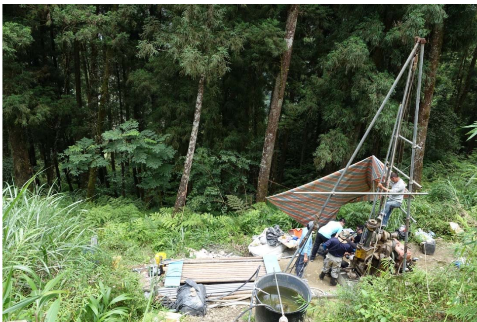
圖 1-10、水壓井鑽設現地施工圖
