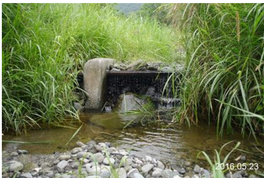
圖 1 - 3 固床工趾部的局部淘刷現象
