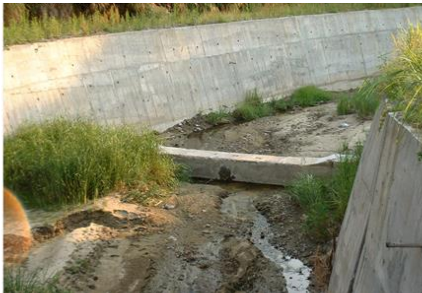
圖 1-2 固床工趾部的局部淘刷現象
