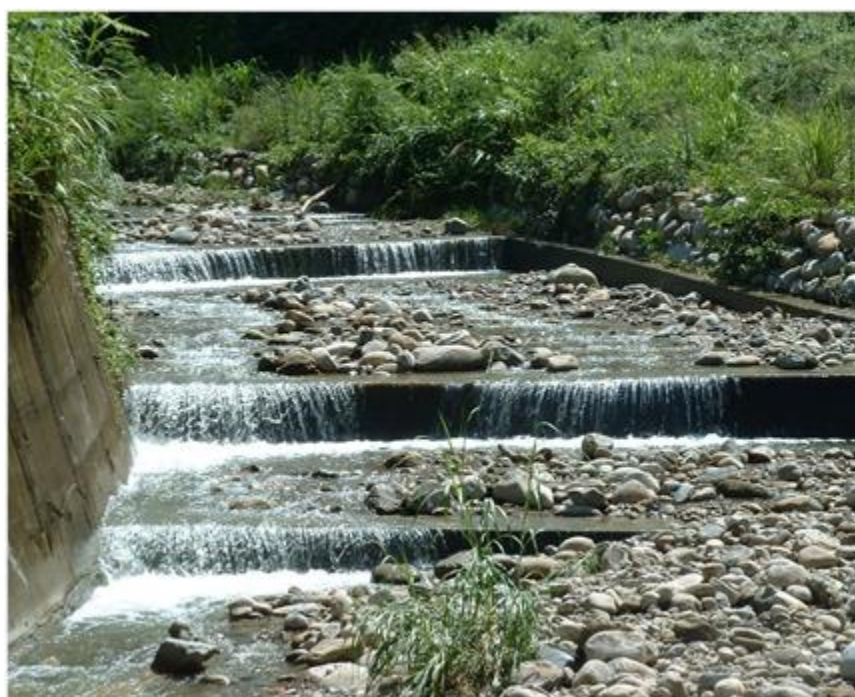
圖 1-1 固床工造成溪床水域的區間化
