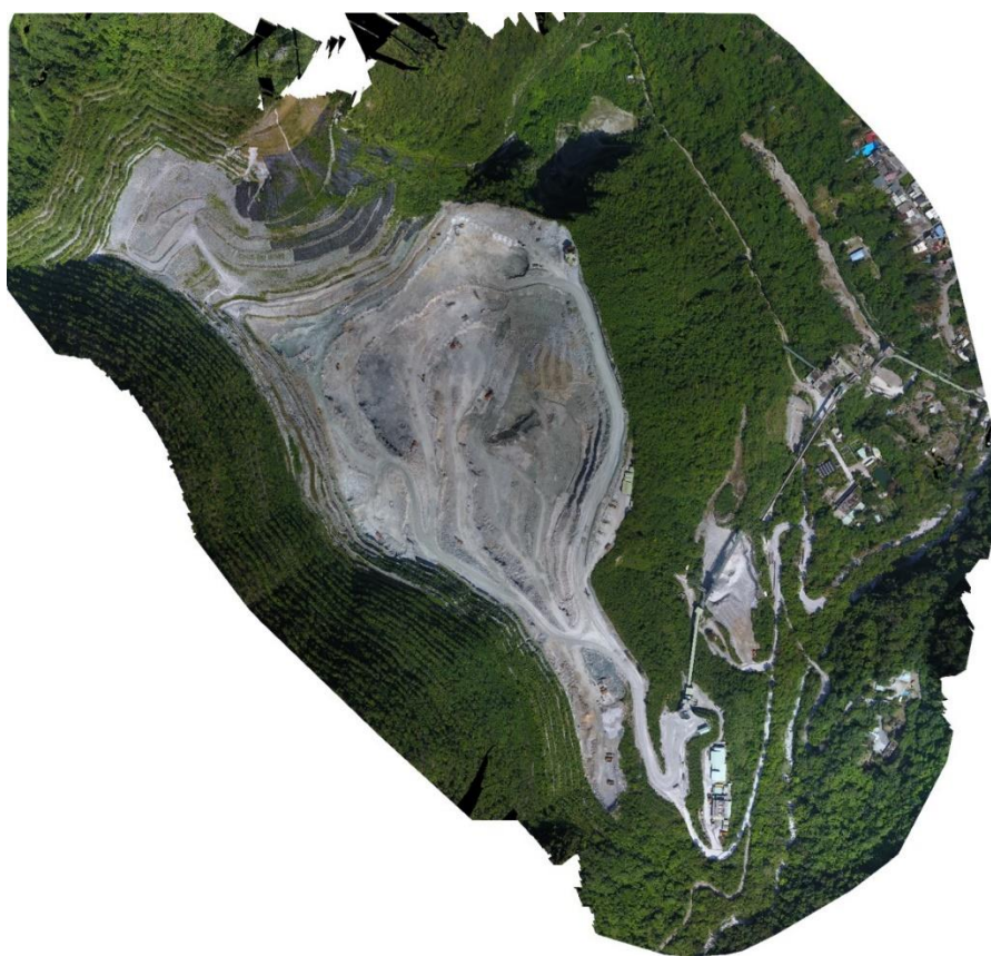
圖 53、亞洲水泥新城山礦場之航拍正射鑲嵌影像圖。
