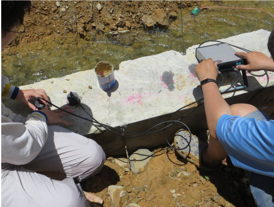
圖 3-24 公林野溪擋土牆之超音波波速量測
