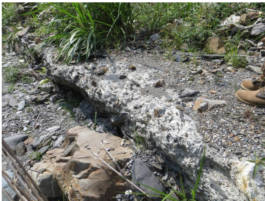
圖 3-32 合望溪構造物之非破壞檢測試驗場址
