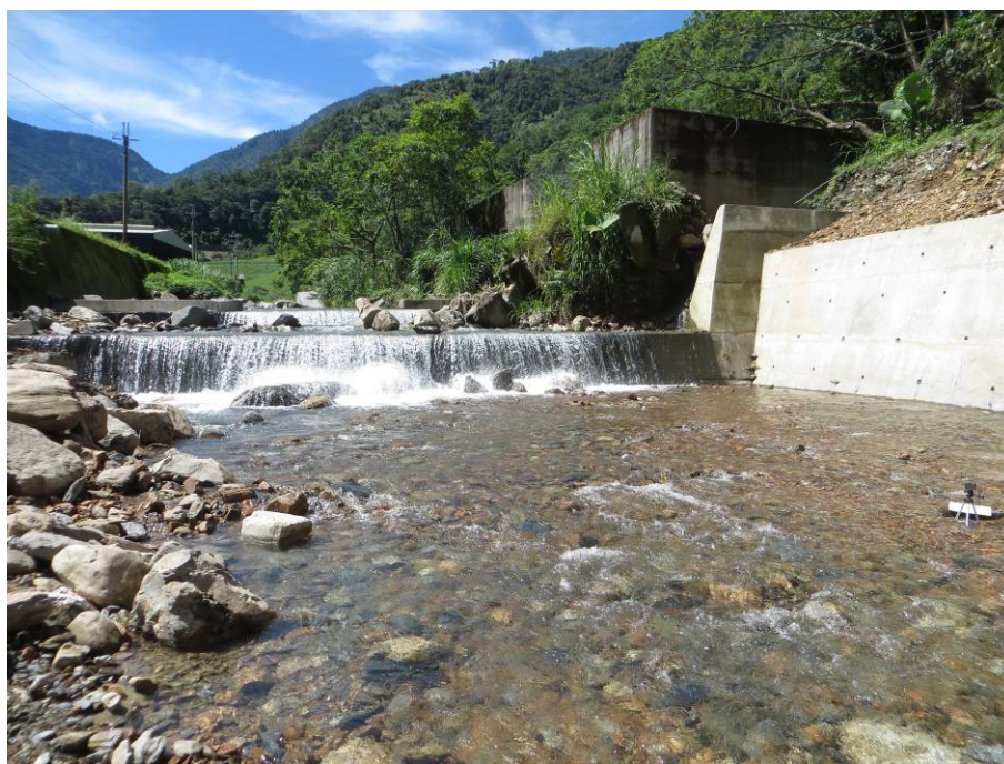
圖 3-18 東光溪上游野溪擋土牆
