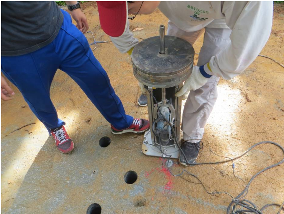
圖 3-27 虎頭山農路工程之微鑽孔試驗
