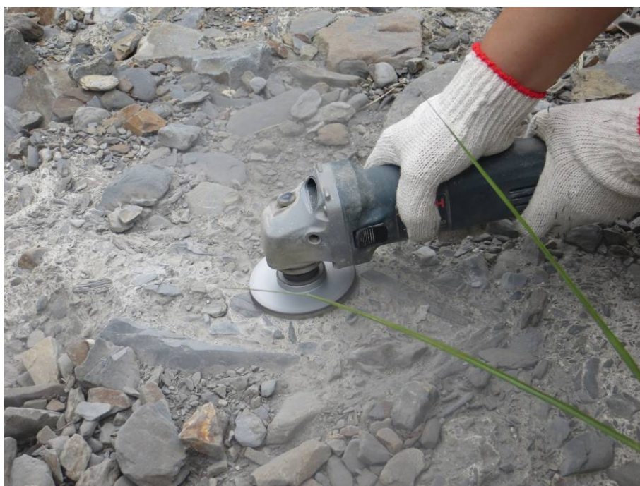
圖 3-33 砂輪機修整混凝土構造物之表面
