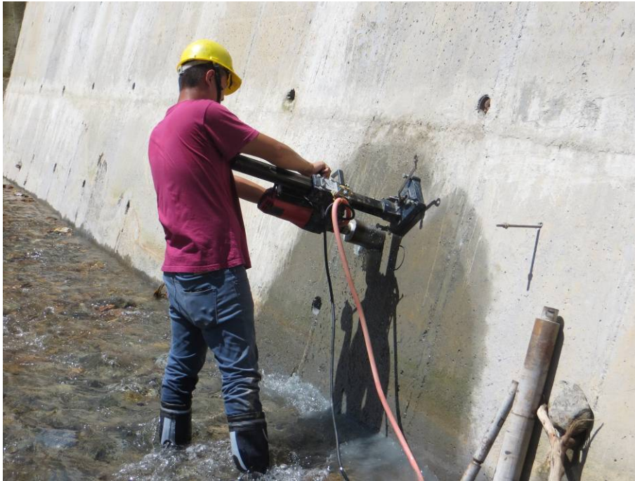
圖 3-21 東光溪上游野溪擋土牆之混凝土鑽心試驗
