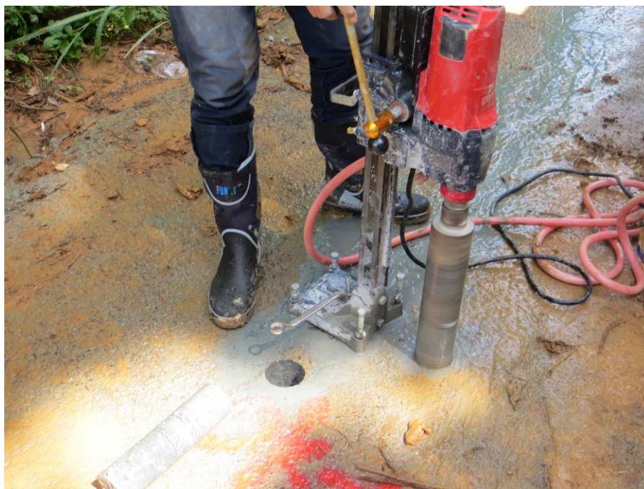
圖 3-28 虎頭山農路工程之混凝土鑽心試驗
