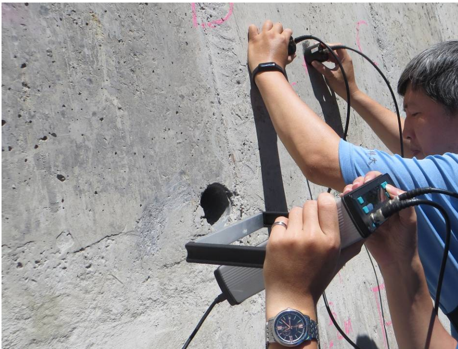
圖 3-20 東光溪上游野溪擋土牆之超音波波速量測
