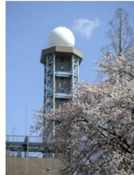
東京レーダー（千葉県柏市）
