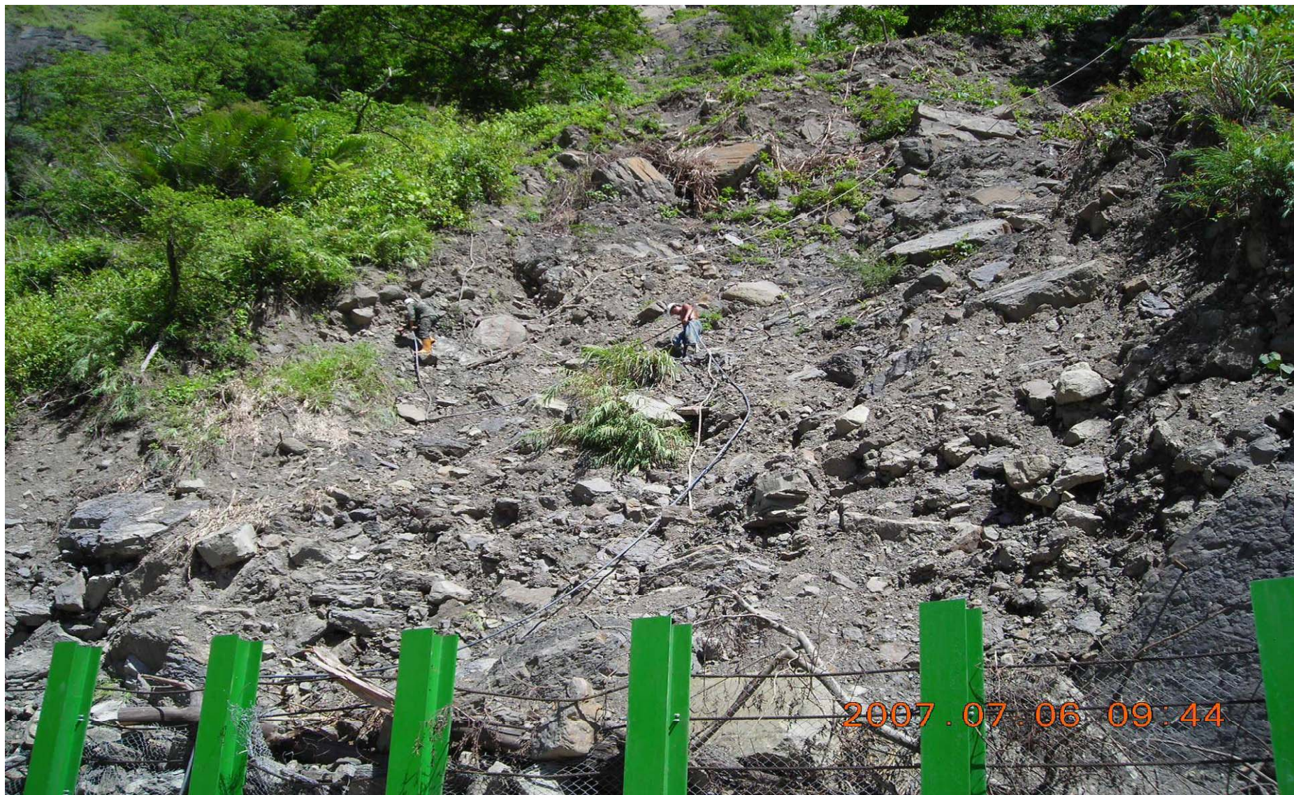
216K+700施工現場邊坡整理
