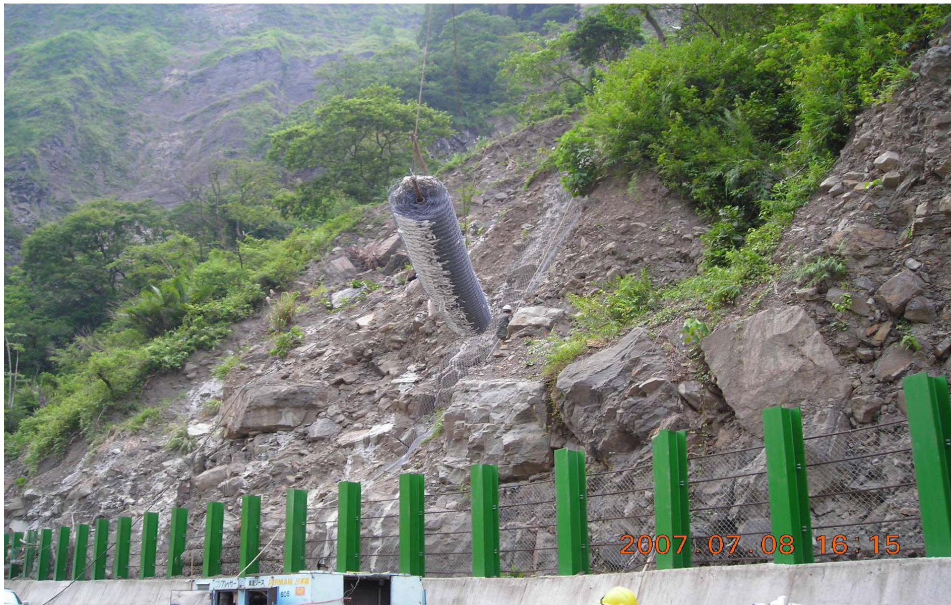
216K+700施工現場防護網吊掛
