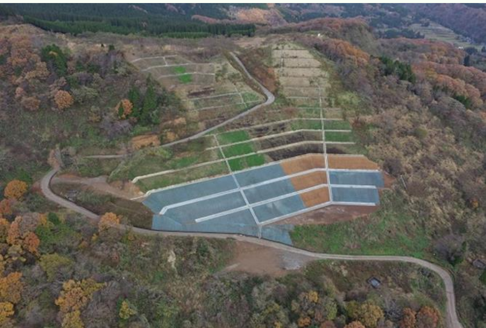
坡頂_排土工法
