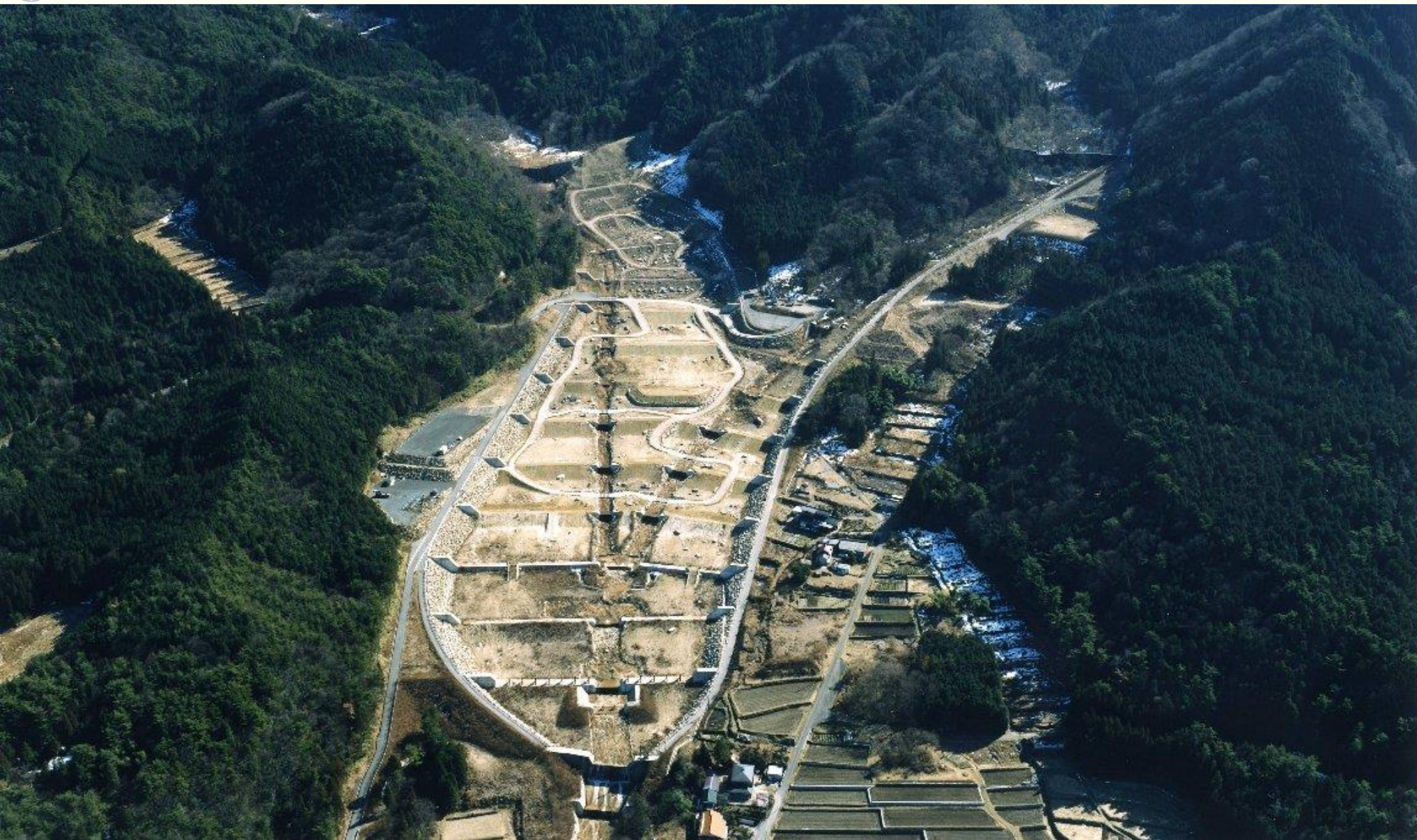
四ツ目川遊砂工
