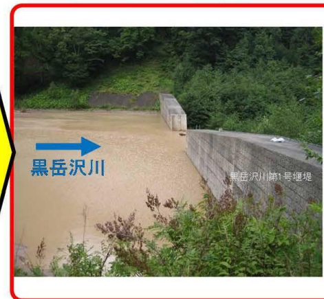
土石流発生直後 (H28.8.23撮影)
