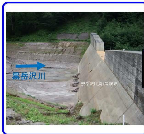
土石流発生前 (H27.8.20撮影)
