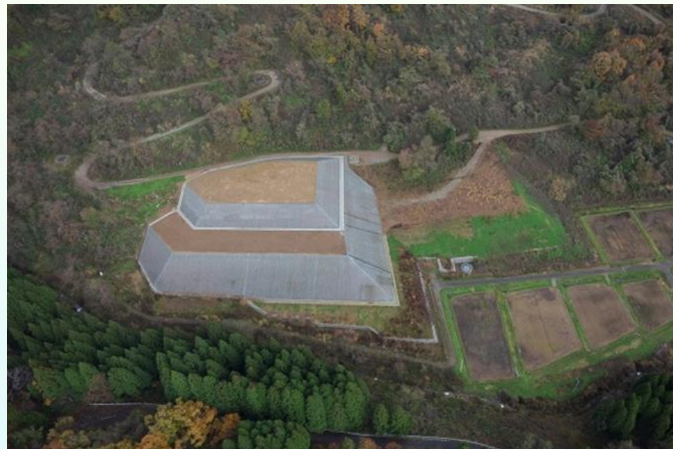
坡趾採壓土工法(配合集水井工)
