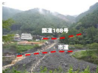
おおとうちょうつじどう 写真 1.1 五條市大塔町辻堂地区 崩壊に伴う土砂が、道路を押し流し、道路が寸断されました。
