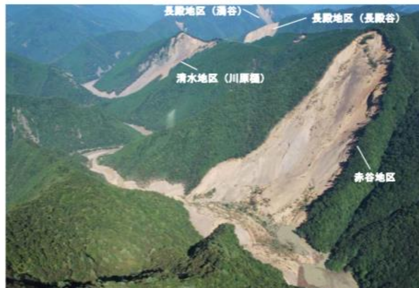
写真 2.1 紀伊半島大水害で深層崩壊が集中して発生した地域の様子 (五條市～十津川村、平成 23 年 9 月 7 日撮影)
