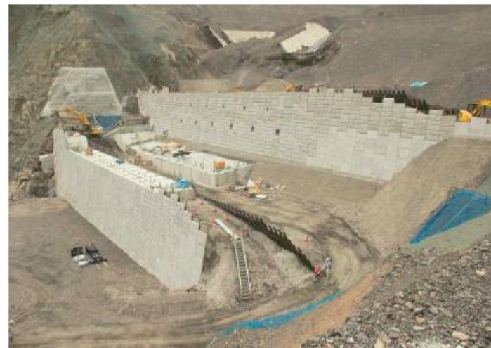
圖3-15 施作2號攔砂壩
