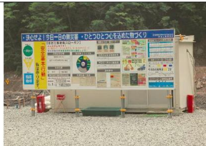
圖3-17 施工現場相關勞安宣導標語
