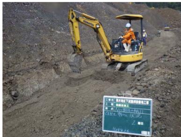
地盤改良工改良土敷均し状況
