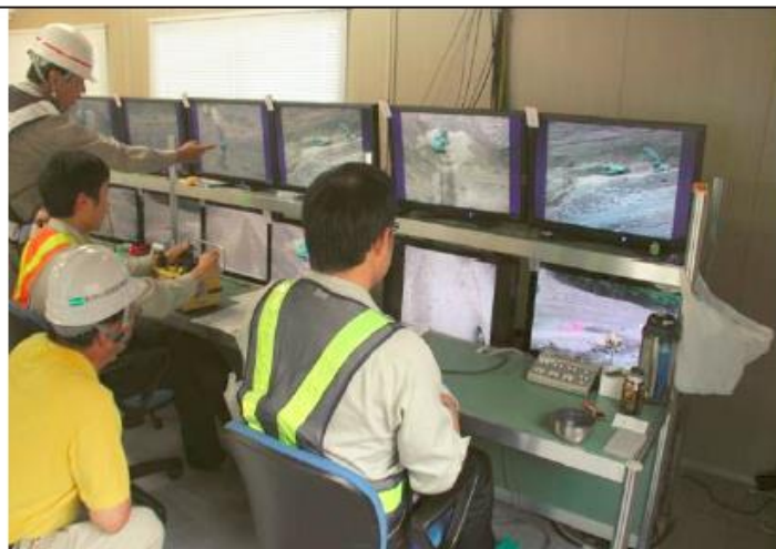
圖3-16 遠端遙控機具進行土砂清除
