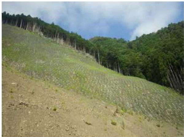
施工完了(8月19日撮影)
