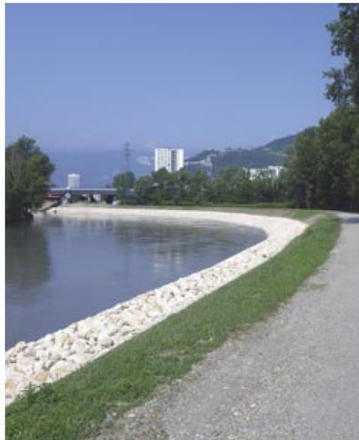
A La Tronche, exemple de talus végétalisé après apport de terre végétale sur le gabion.
