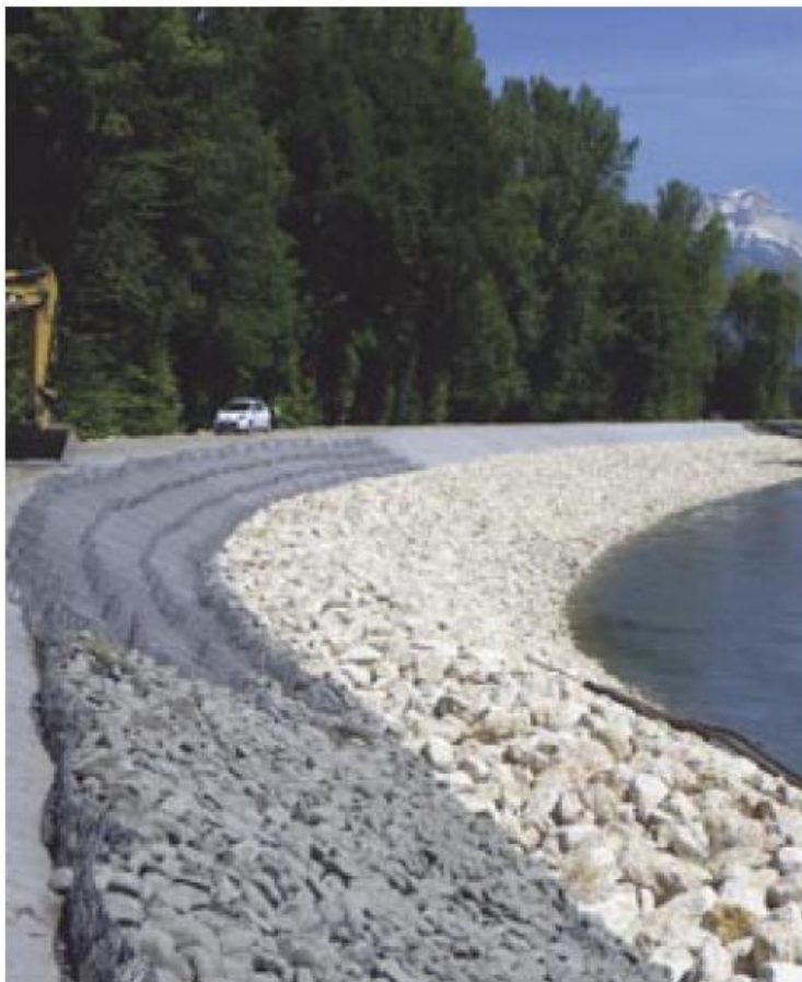
A Meylan, dans la boucle de Grangeage, exemple de mise en place de gabions (cailloux maintenus par des grillages) au-dessus de la partie enrochée.
