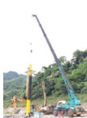
觀測樁鋼管續接
