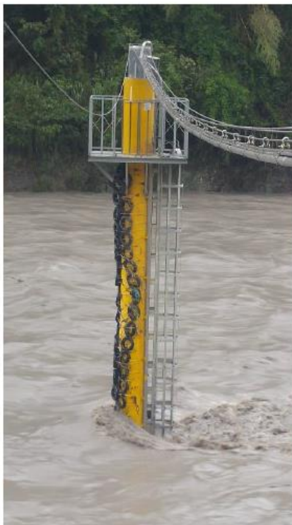
摘圖-2 梅姬颱風過後緩衝材位移照片(2016/09/28 06 時)
