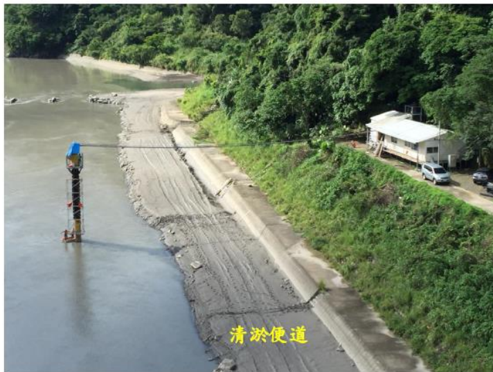
圖 2-12 羅浮站泥砂監測系統現況配置
