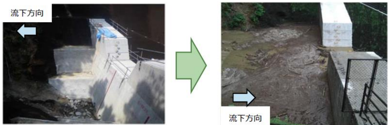
圖 21 以防砂壩攔阻土砂 (左：攔阻前 右：攔阻後)
