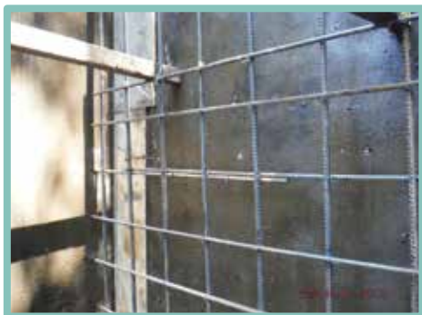
▲ 鋼筋垂直間距不符設計
