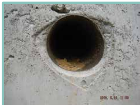
▲ 使用薄管不符規定
