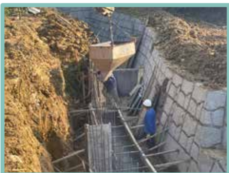
▲ 使用漏斗裝置進行澆置
