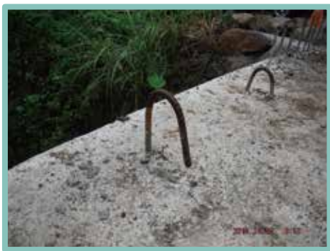
▲ 僅在構造物邊緣處設立剪力筋
