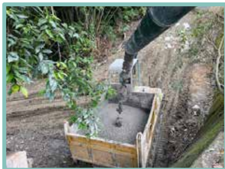
▲ 混凝土澆置區段過遠宜小搬運方式加強拌合澆置
