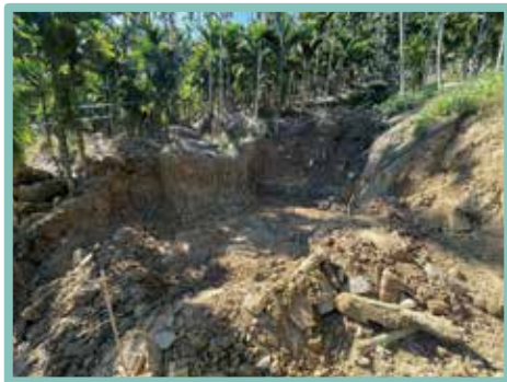
▲ 開挖放樣高程未達設計高程
