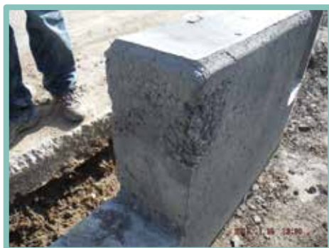
▲ 塊狀護欄模板未緊密而漏漿形成蜂窩
