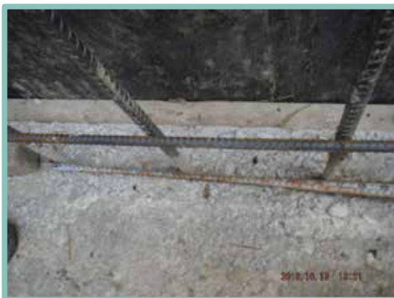
▲ 鋼筋跳步綁紮
