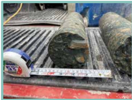
▲ 鑽心斷面粗骨材大於混凝土配比標稱粒徑值
