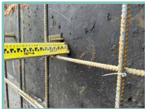
▲ 設鋼筋間隔器
