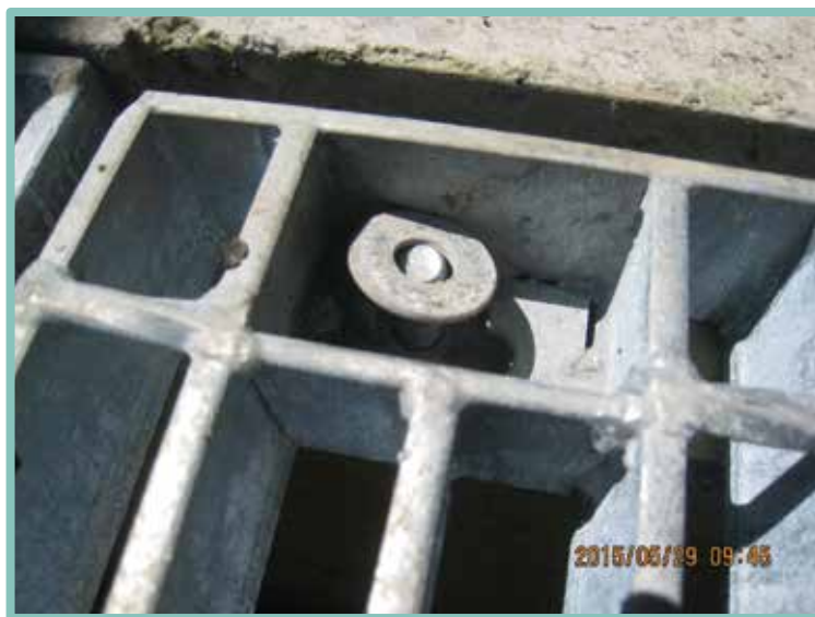
▲ 鍍鋅隔柵板缺少五金零件螺帽
