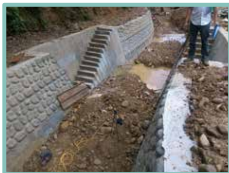
▲ 護岸處預留銜接鋼筋
