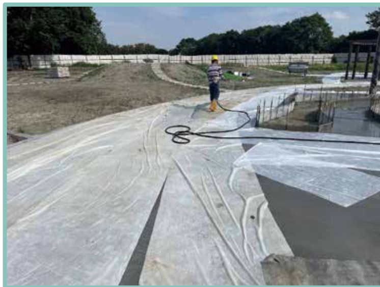
▲ 澆置完成後鋪不織布進行灑水養護
