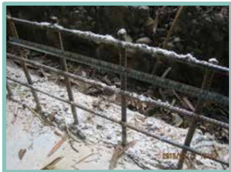
▲ 鋼筋跳步綁紮
