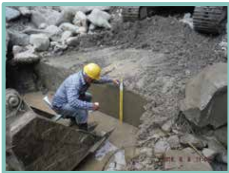
▲ 進行開挖檢測固床工基礎深度
