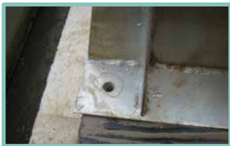
▲ 缺漏五金零件
