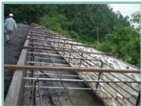
▲ 擋土牆底板處完成模板組立內泥砂淤積
