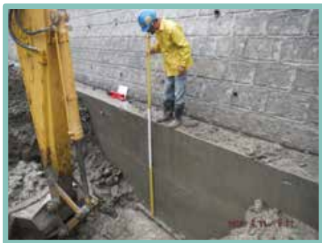
▲ 進行開挖檢測護岸基礎深度
