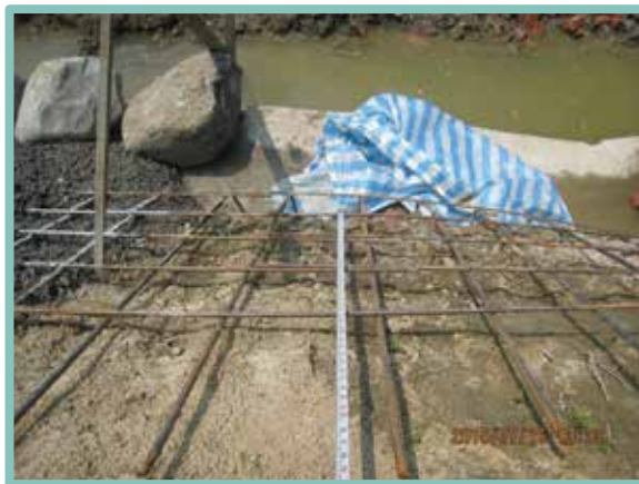
▲ 護坡底板相鄰鋼筋搭接同一斷面
