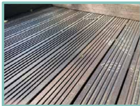
▲ 木棧道板材防滑溝槽措施
