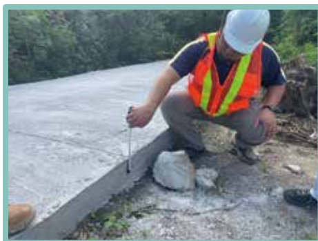
▲ 路面收邊以模板組立且厚度達設計標準 宜考量設計土袋包收邊
