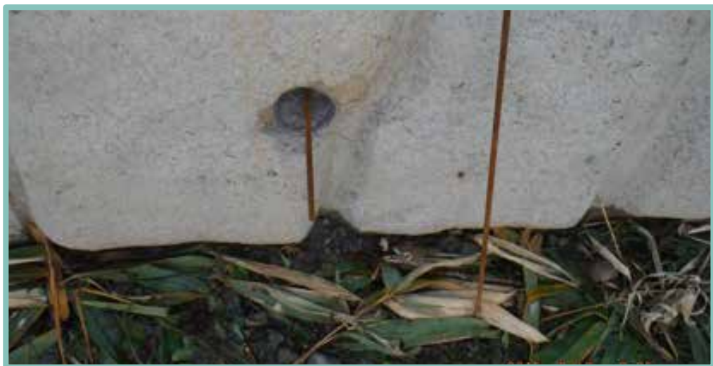
▲ 組立模板之螺桿穿入洩水管
