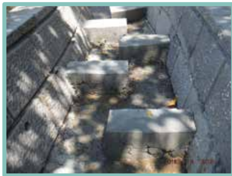
▲ 消能檻模板未緊密而漏漿形成蜂窩
