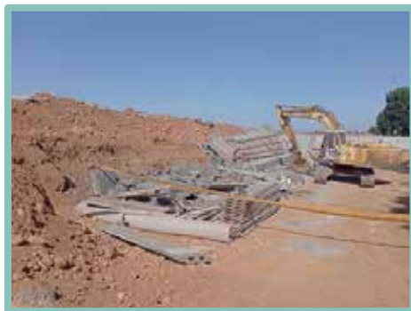
▲ 未依規定時間拆模及回填
