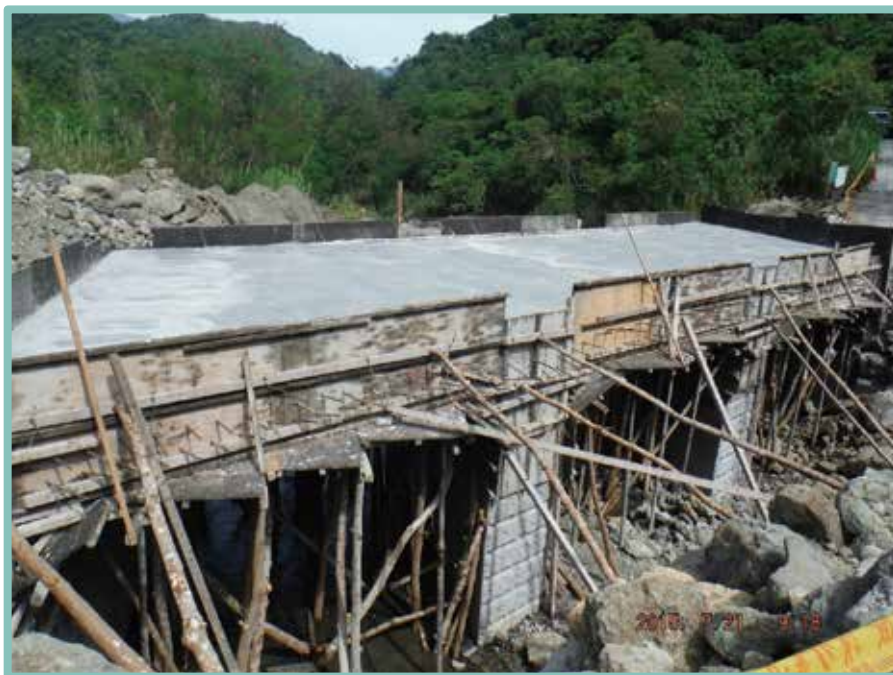
▲ 過水路面澆置風大、高溫應加強養護
