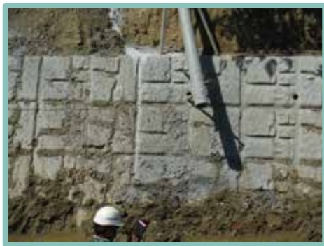
▲ 落下高度超過 1.5m 建議置入鐵船內拌合後方能澆置
