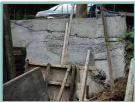
▲ 擋土牆相鄰各層間隔時間久而無法密合
