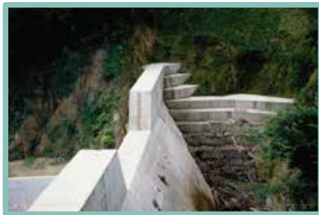
▲ 因壩翼開挖過大以混凝土階梯方式改善
