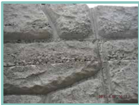
▲ 護岸模板未緊密而漏漿形成蜂窩
