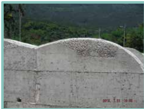
▲ 混凝土搗實未確實造成蜂窩
