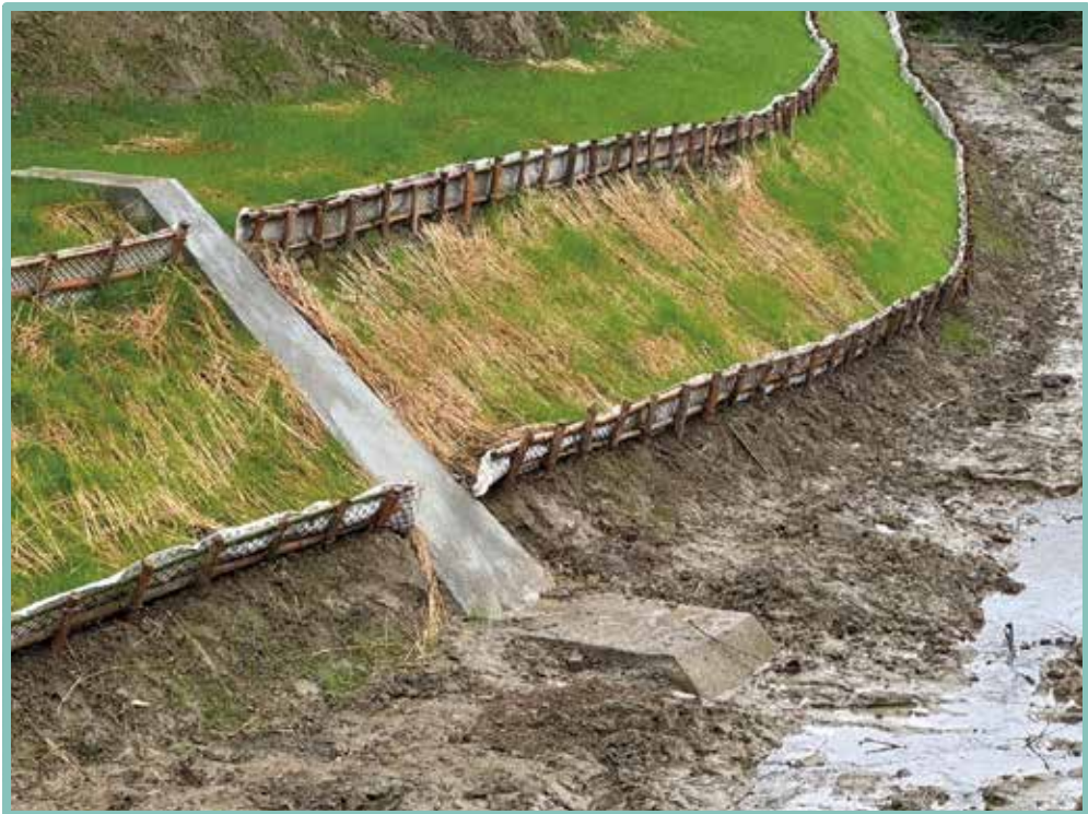
▲ 確保地盤處理完善立於施工完整
