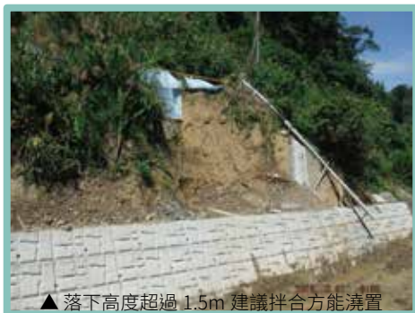
▲ 落下高度超過 1.5m 建議拌合方能澆置
