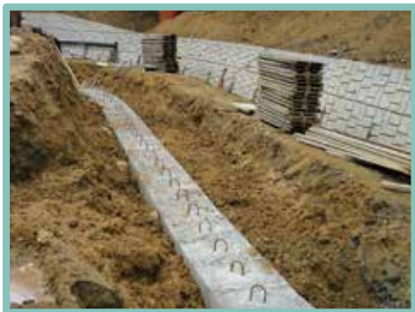
▲ 施工縫設立剪力筋應符合設計
