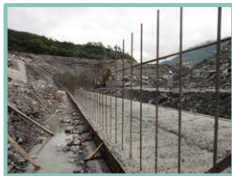
▲ 不符設計要求未設立施工縫
