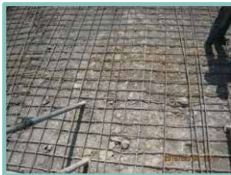
▲ 鋼筋未確實綁紮以致間距不符設計大小
