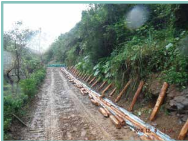
▲ 木作擋土設施確認高程與放樣區位
