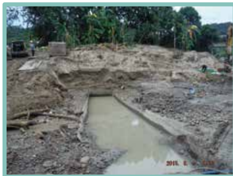
▲ 開挖區域積水進行抽水機抽排
