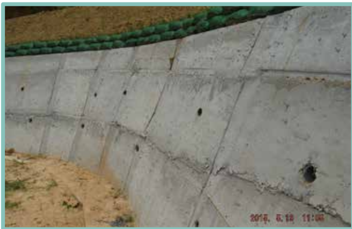
▲ 擋土牆各層斜率不同不符設計
