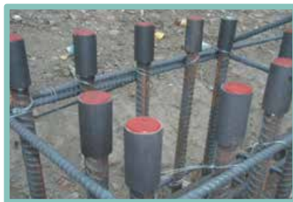
▲ 相鄰鋼筋於同處續接
