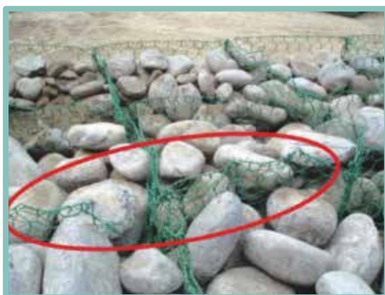
▲ 以怪手裝填破壞箱籠鐵絲
