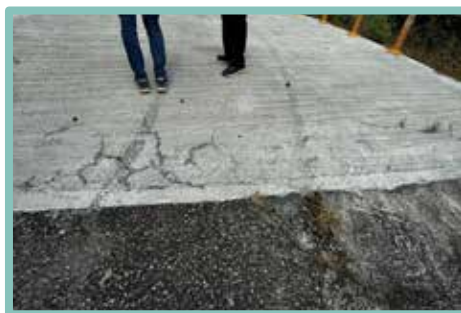
▲ 新舊界面未妥善處理造成路面破裂而污染
