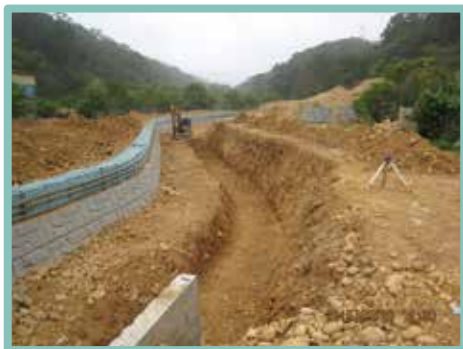
▲ 重新檢視開挖區位高程確保放樣正確
