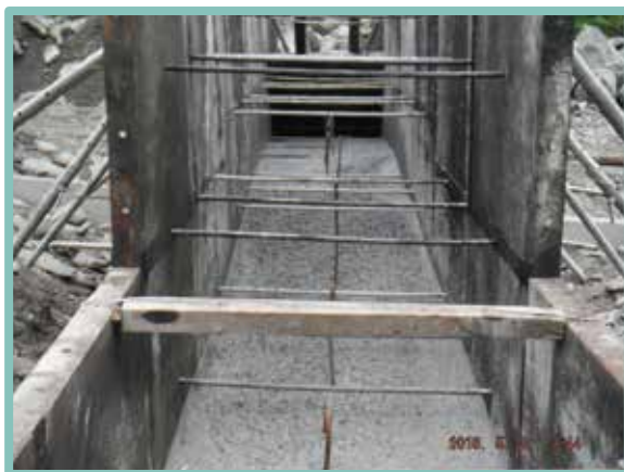
▲ 不符設計要求於分層澆置 埋入木條形成凹槽施工縫
