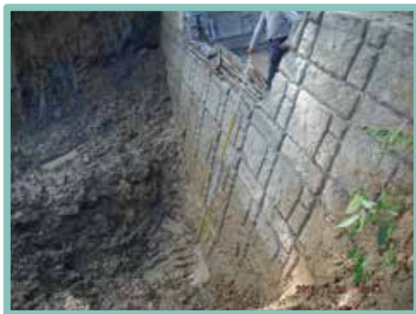
▲ 進行開挖檢測固床工基礎深度
