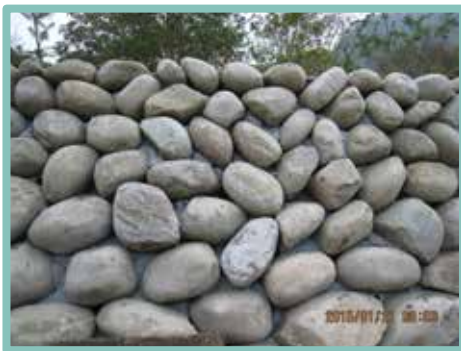
▲ 漿卵石護岸圍砌方式不正確
