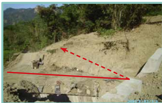
▲ 溢洪口留心處偏向右岸
