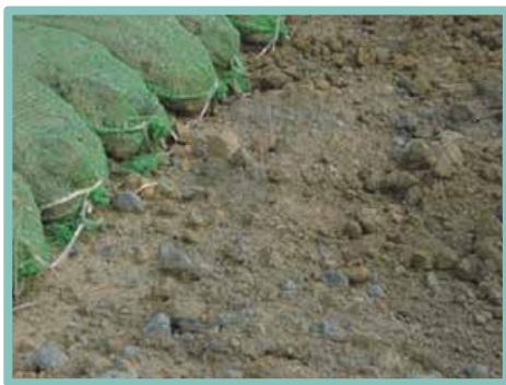
▲ 基礎表面未清除
