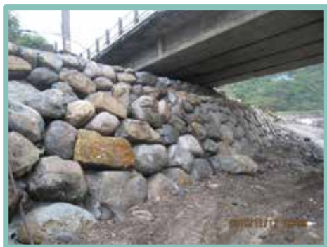
▲ 建議使用斜率板以符合圖說設計
