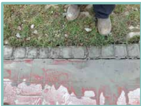
▲ 高壓磚破損
