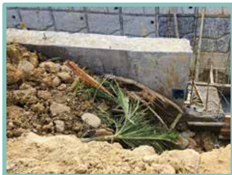
▲ 回填處有機物堆積應予以移除避免回填
