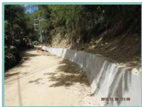
▲ 擋土牆銜接處線型折角明顯
