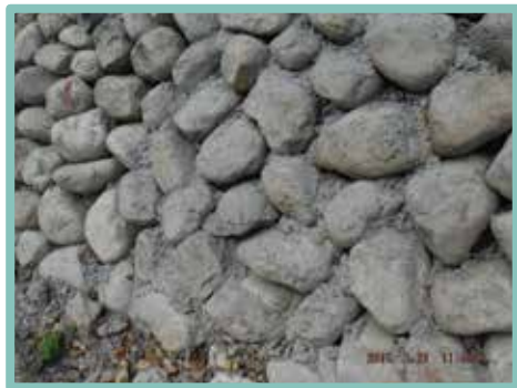
▲ 卵塊石未清潔而使用且混凝土漿汙染塊石表面
