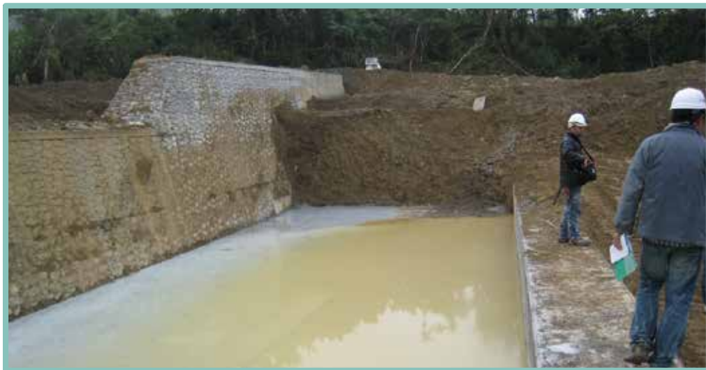
▲ 大規模開挖壩翼施作應確認分層回填夯實，避免水流沖刷壩翼獨立河道中
