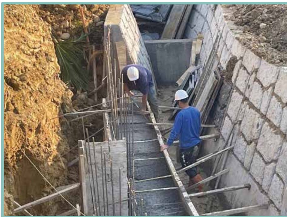
▲ 護岸基礎澆置加強混凝土搗實
