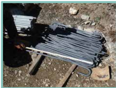
▲ 確認鋼筋尺寸符合設計規定
