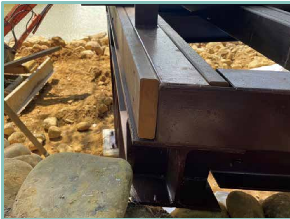
▲ 材料尺寸不符因而切割加強防腐
