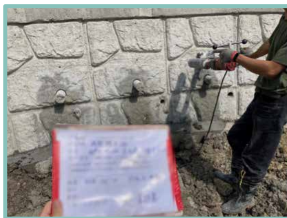
▲ 未辦理試體製作進行混凝土鑽心取樣辦理抗壓試驗
