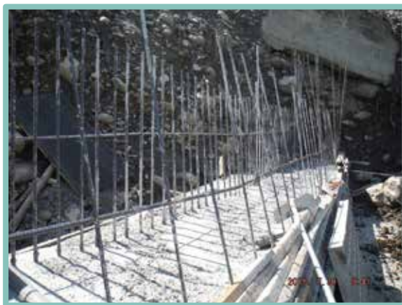
▲ 不符設計要求未設立施工縫
