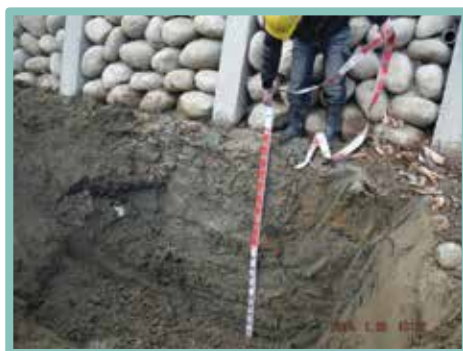
▲ 進行開挖檢測護岸基礎深度
