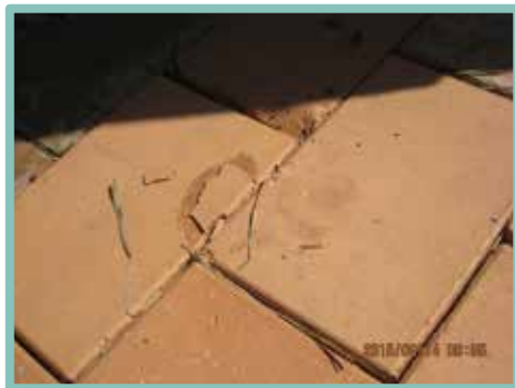
▲ 透水磚破裂
