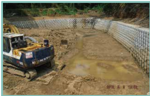
▲ 調整池底高程進行整地
