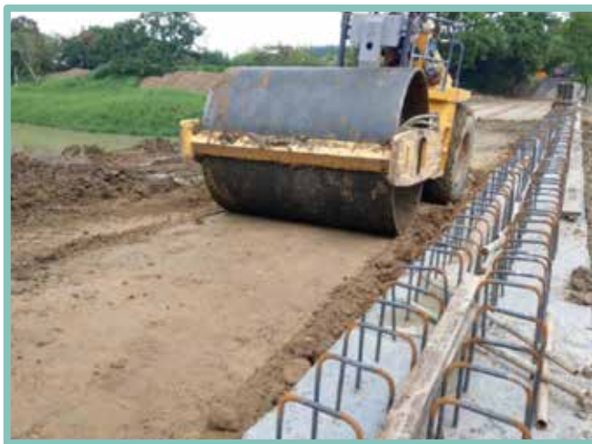
▲ 土壩夯實不足再次滾壓夯實
