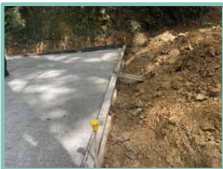
▲ 路面收邊以模板組立
