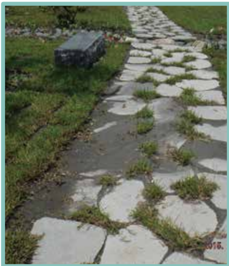
▲ 石板步道放樣高程未確實以致步道積水
