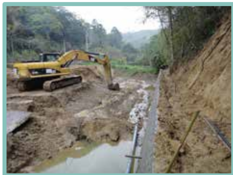
▲ 土質泥濘軟弱造成挖土機無法施工
