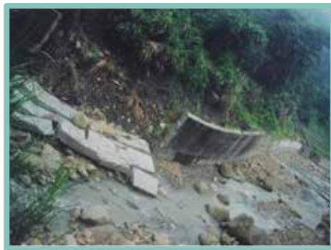
▲ 護岸基礎深度不足而倒塌
