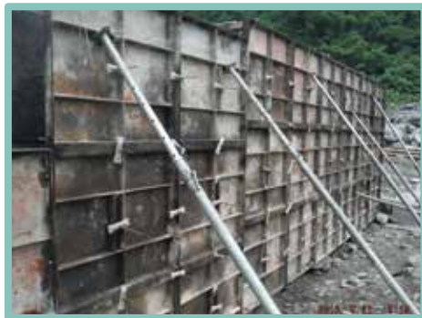
▲ 澆置巨積混凝土確認模板承載力是否充足
