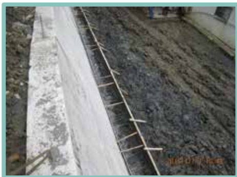
▲ 擋土牆址板完成組立模板內大量泥沙
