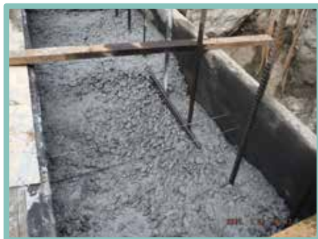
▲ 分層澆置應針對混凝土與模板交接處確實搗實
