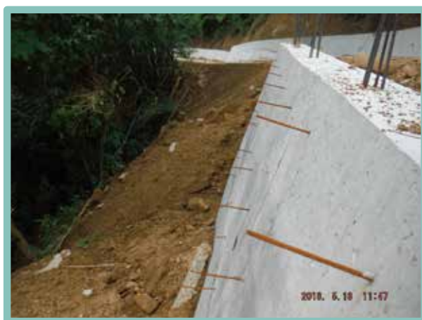
▲ 下邊坡擋土牆混凝土表面螺桿未清理
