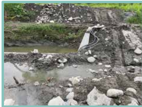
▲ 開挖區域積水進行抽水機抽排
