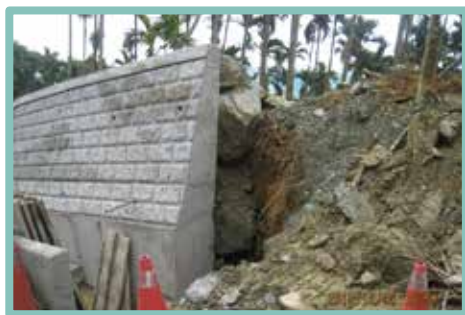
▲ 擋土牆未設結束工卻以塊石填在背填處
