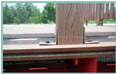
▲ 五金零件鎖固未確實
