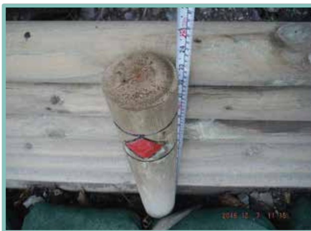
▲ 木製桿件切割未塗防腐、防蟲、防蟻塗料
