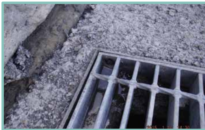
▲ 鍍鋅隔柵板缺少五金零件插銷
