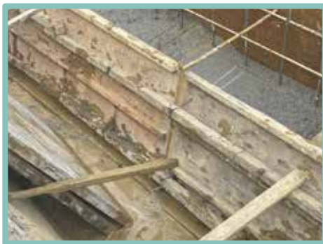
▲ 不當使用其他材料作為模板隙縫修補
