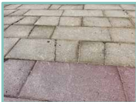
▲ 高壓磚破損
