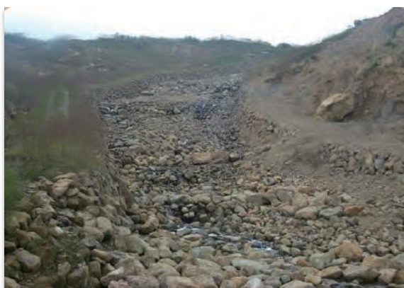
緊急溢洪道工程
