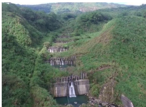
柱狀透過性潛壩工程
