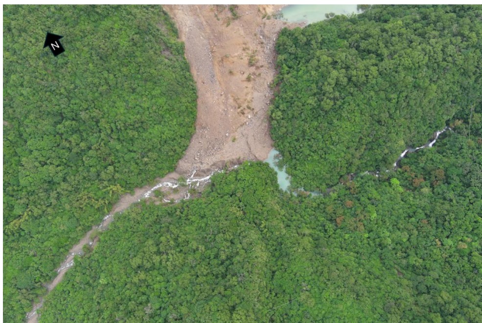
圖 8 南側蓄水區 (拍照日期 113/10/9)
