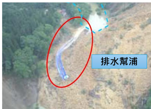
排水幫浦施作情形
