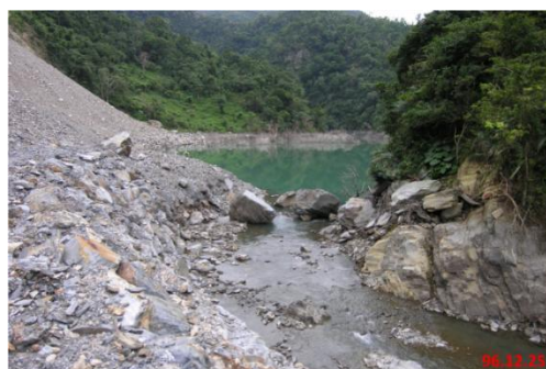
龍泉溪堰塞湖第一次降挖工程
