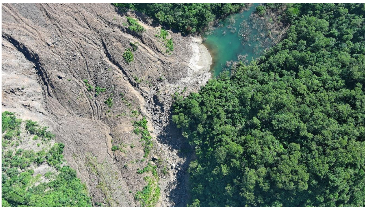
圖 17 溢洪道現況 (拍照日期 114/10/9)
