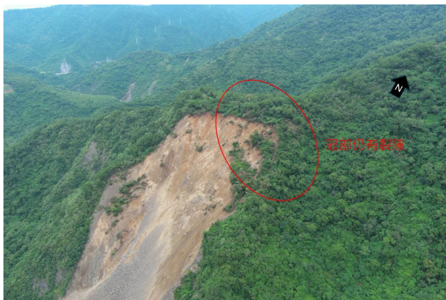
圖 5 崩塌區現況 (拍照日期 113/10/9)
