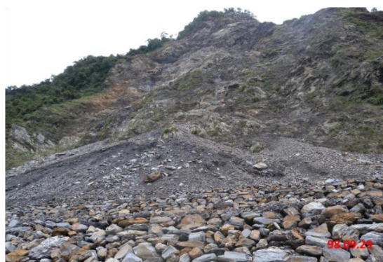
崩塌區坡腳護坡工程
