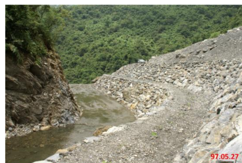
龍泉溪堰塞湖第二次降挖工程
