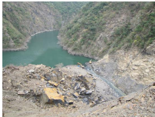
士文溪堰塞湖溢洪道開挖工程
