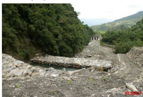
龍泉溪堰塞湖堆石潛壩及護岸工程
