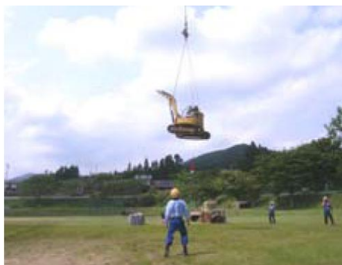
直升機空運小型重機具零件
