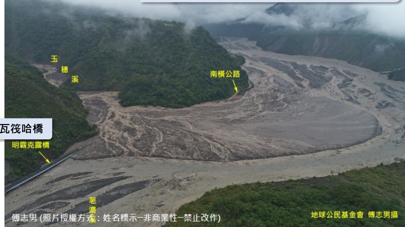
2021年盧碧颱風玉穗溪出流口-明霸克露橋 (台20線南橫公路)因不安定土砂受災情形
