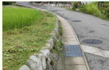
道路無人行道之緊鄰水圳溝渠或陡坡安全防護設置案例
