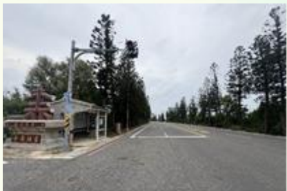
未設置號誌及行人穿越標線
