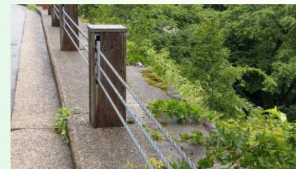
道路無人行道之緊鄰水圳溝渠或陡坡安全防護設置案例
