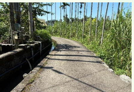
路旁水圳溝渠無防護措施與路面不平整、有高低落差
