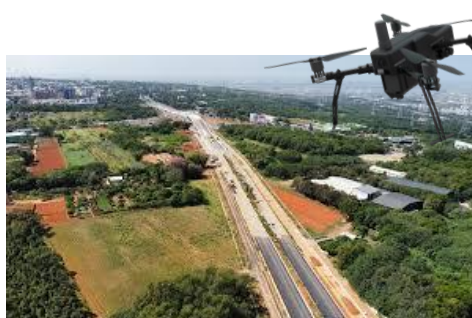
■ 無人機自動巡檢拍照 (無須人力走路巡查)
