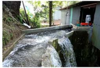
井手野毘沙門堂發電所
