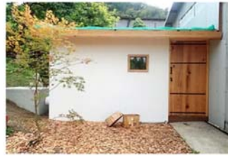
白糸小水力發電所
