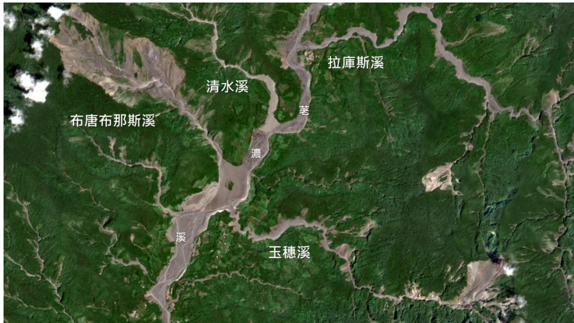
圖 1-4 山區群發性主支流土砂流出案例 - 老濃溪集水區
