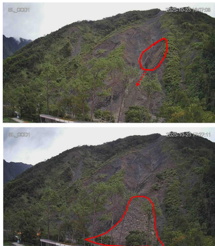
圖 3-38 秀巒崩塌地發生大規模土砂下移前後對比圖
