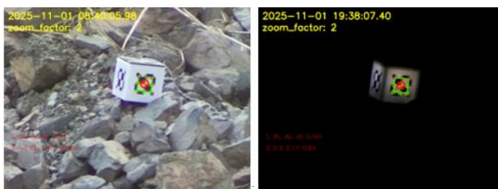
圖 3-40 電腦視覺變位監測儀器日夜間監測截圖
