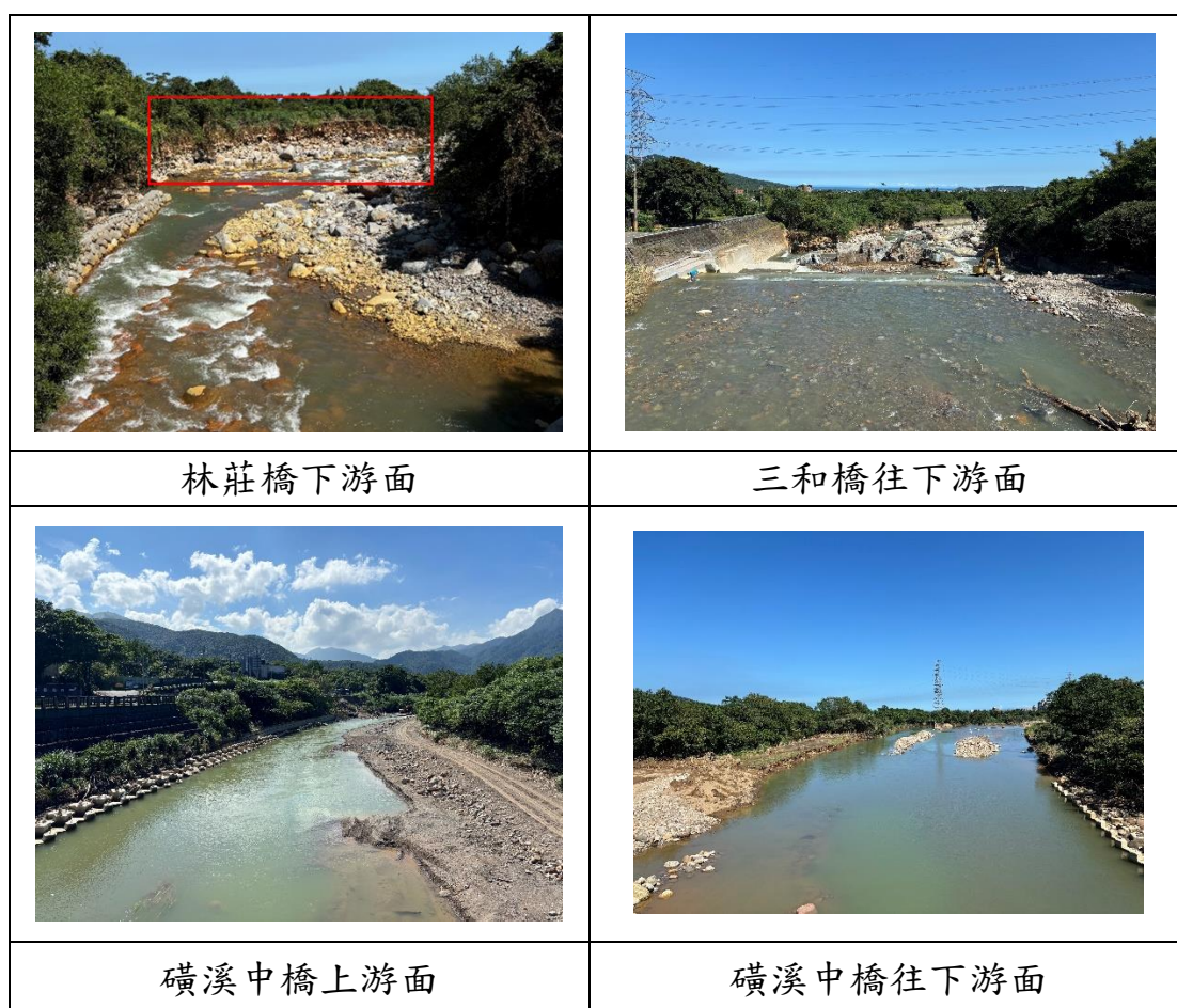
圖 2-21 113 年 10 月 19 日現地勘察照片
