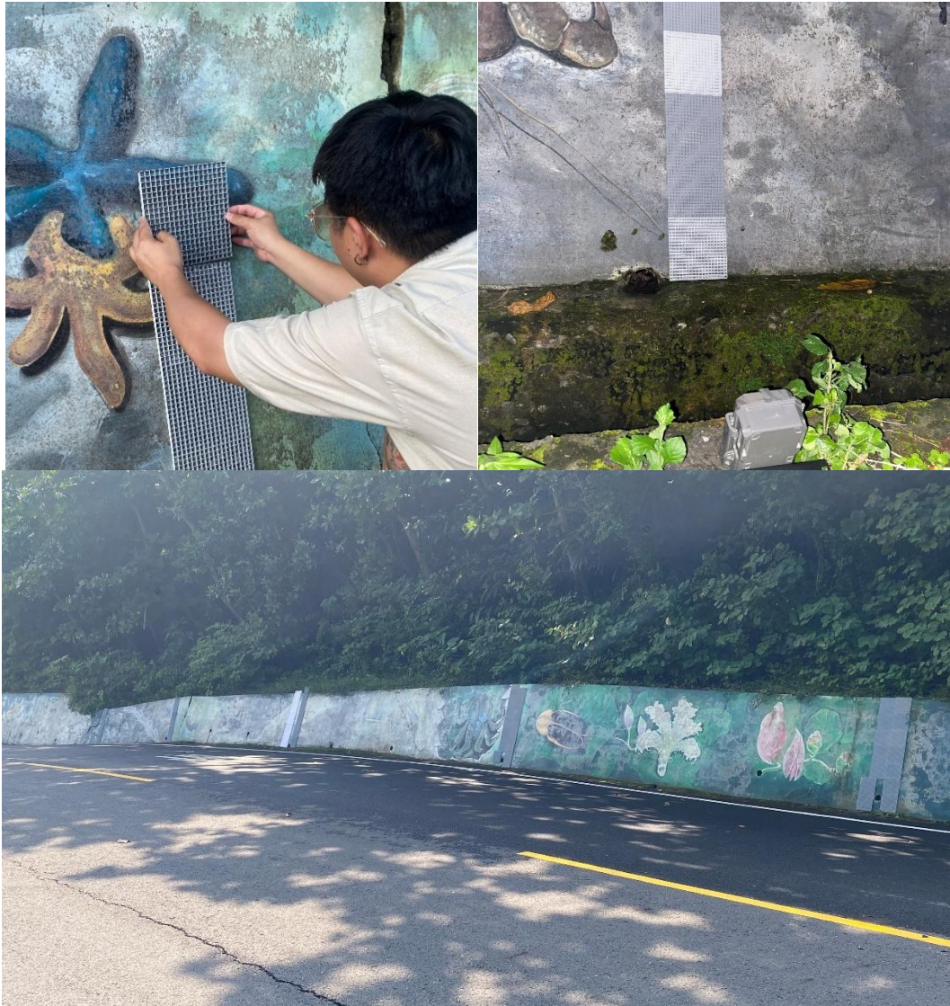
圖 17 小琉球實驗場域架設情況（美人洞擋土牆）
