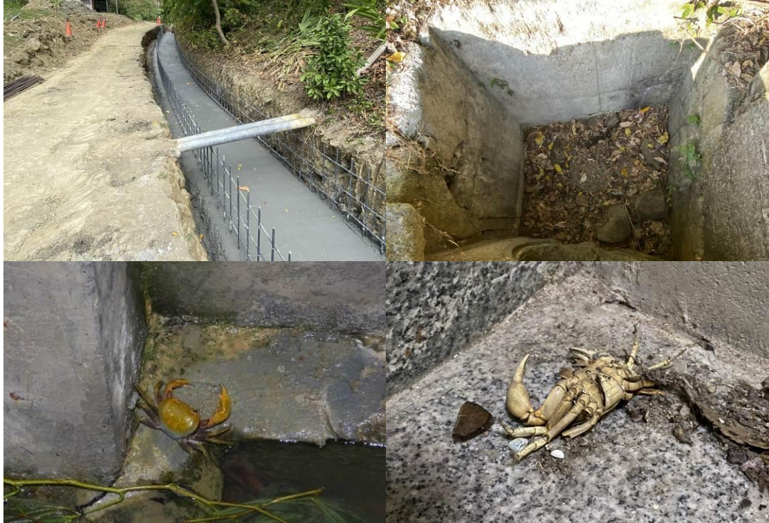
圖 1 人工結構物對小型動物垂直通行之影響
