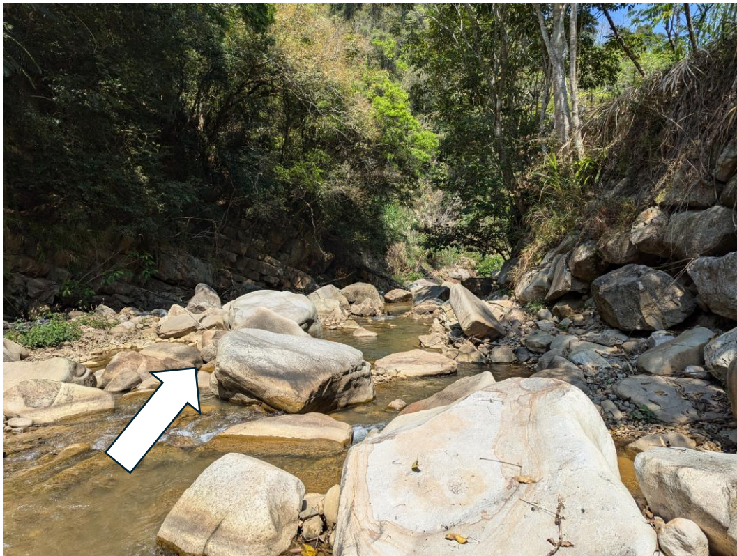
圖 4.2-1、玉門關天然河段河岸。箭頭為河流方向。右岸可見乾砌石結構、左岸則是天然的露頭河岸。
