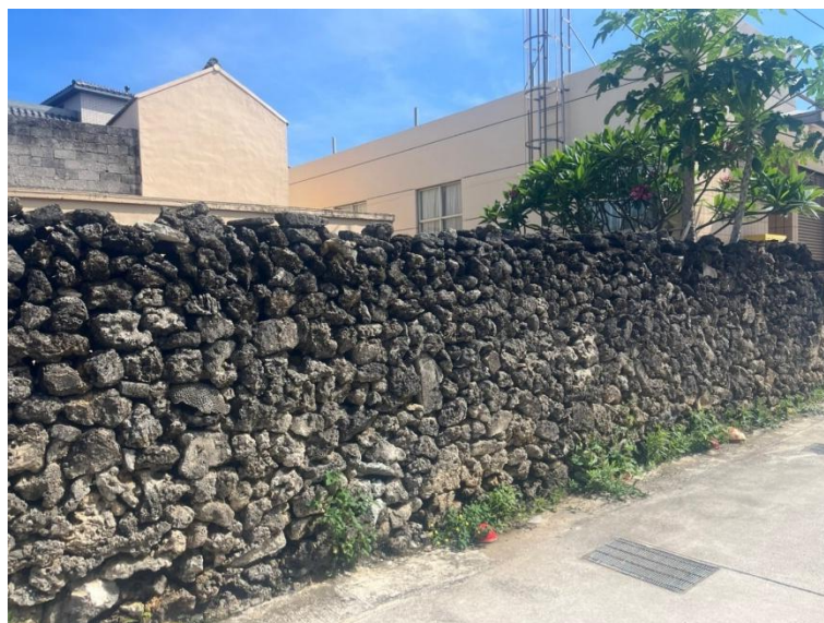
圖 5-2 南寮社區傳統砵砵石牆
