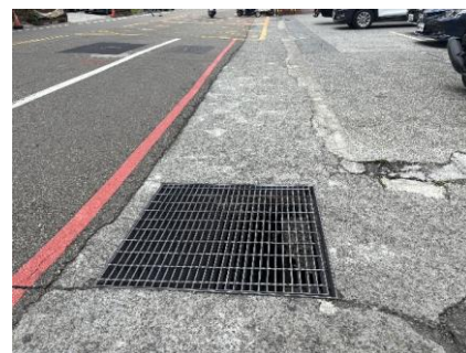
AC 道路與 PC 側溝鋪面銜接處案例
