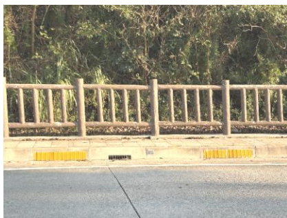
側溝水泥混凝土溝蓋鋪面處理案例
