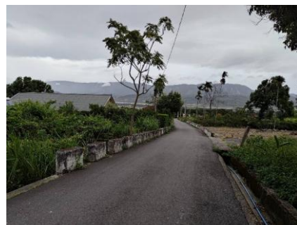
部分農路巷道為水泥鋪面，但側邊溝渠或有高地落差處多已設置水泥墩或欄杆
