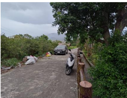
部分農路巷道為水泥鋪面，但側邊溝渠或有高地落差處多已設置水泥墩或欄杆
