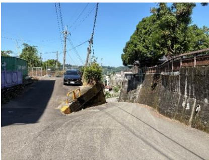
社區內不同材質的道路介面不平整，且坡度較陡，安全性較低
