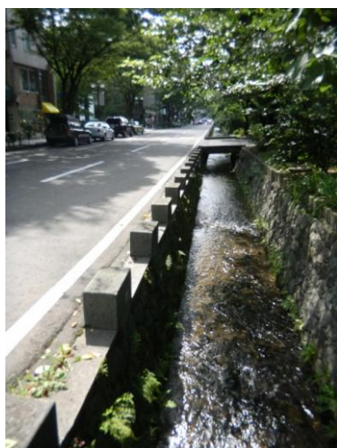
道路無人行道之緊鄰水圳溝渠或陡坡安全防護設置案例
