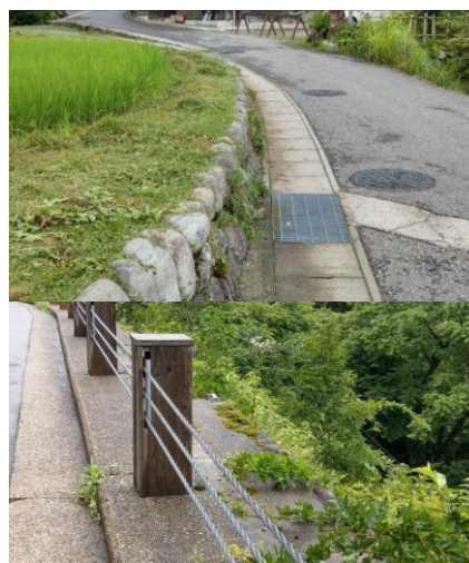
道路無人行道之緊鄰水圳溝渠或陡坡安全防護設置案例
