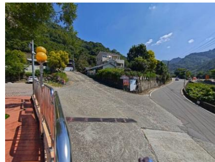
社區內不同材質的道路介面不平整，且坡度較陡，安全性較低
