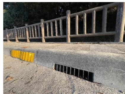
側溝水泥混凝土溝蓋鋪面處理案例
