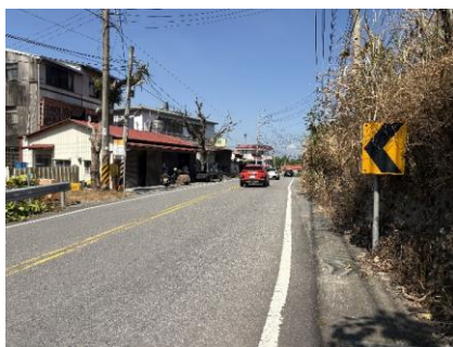
AC 道路與 PC 側溝鋪面銜接處案例
