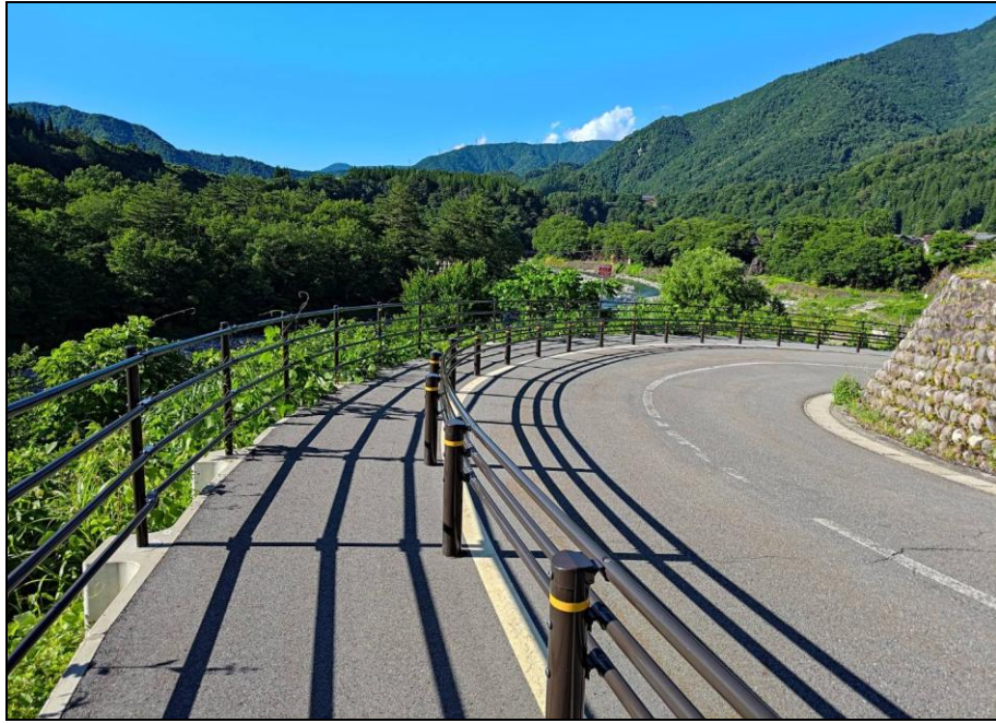
圖 2-5 車道邊界防護欄
