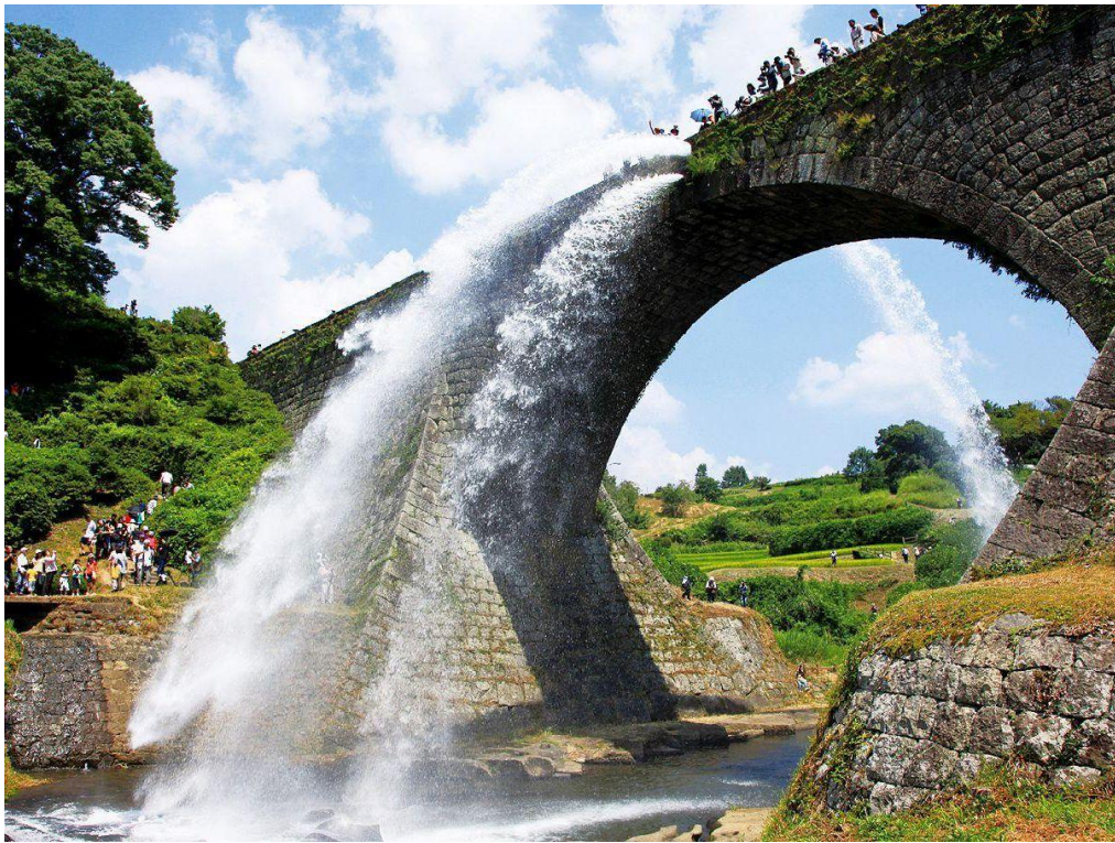
圖 3-7 日本熊本縣山都町通潤橋(照片來源：Japan Travel)
