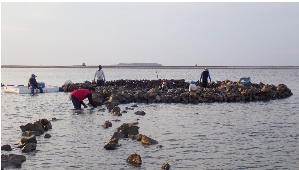
圖 3-9 石滬修復過程(照片來源：stoneweir.info)
