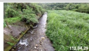
重光橋下游河道現況
