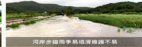
濕地雨後沉降作用明顯，傳統乾砌石板、階梯等結構物不易固定、
