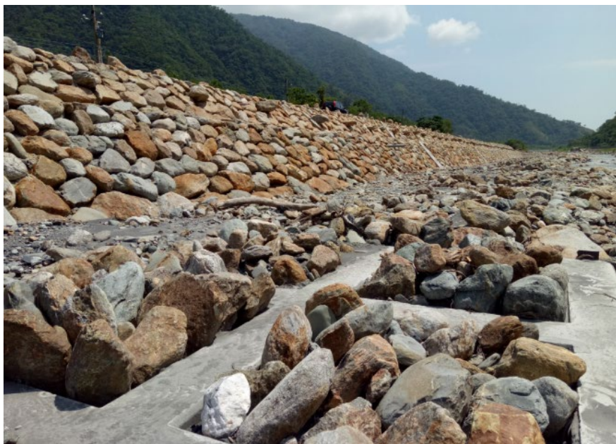
圖 2-6 混凝土砌石護岸
