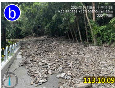
支線坑溝土砂流出堆積農東金202道路
