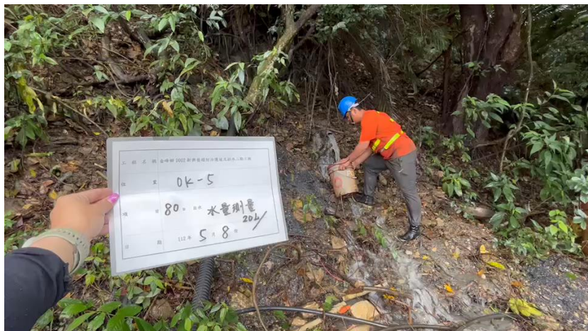
20230505_B工區_0K-005_80m施工後3天出水情形
