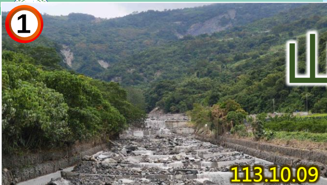
東縣DF076邊坡崩塌及河道土石堆積
