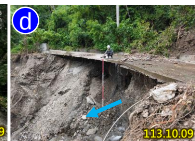
現生崩塌地(2024-02)坑溝逕流沖刷，農東金002路基淘空，影響路段長約20m
