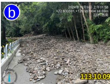
現生崩塌地(2024-02)坑溝逕流冲刷，農東金002路基淘空，影響路段長約20m
