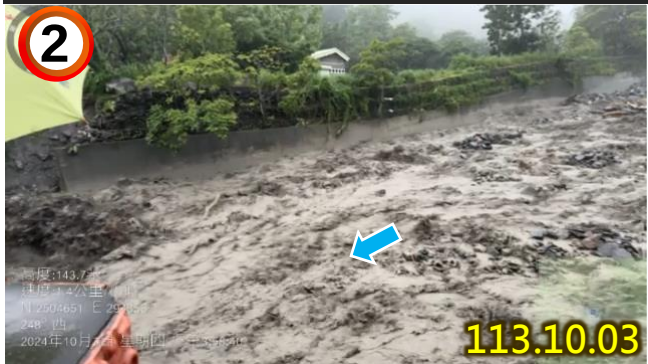
東縣DF076含砂沖刷豐收橋右岸淘空 緊急補強，橋體於10/04凌晨遭沖毀
